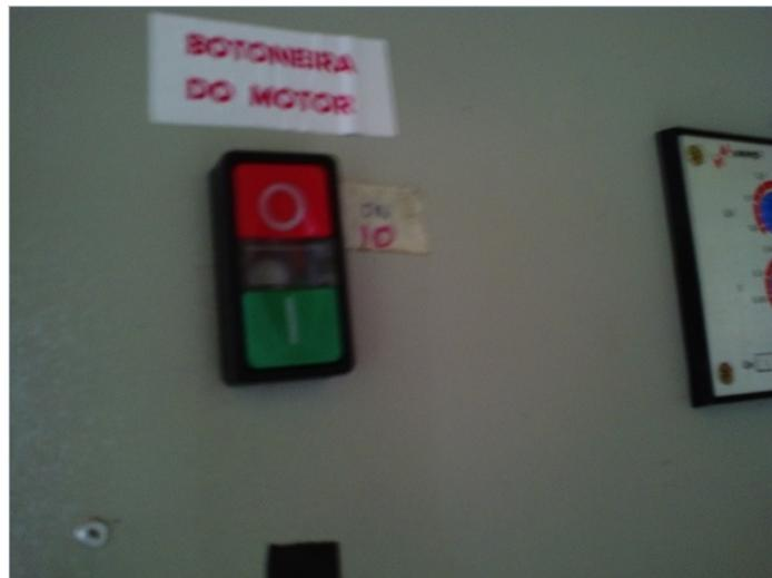
Figura 7.5: Chave CH10 de acionamento do motor CC da comporta
