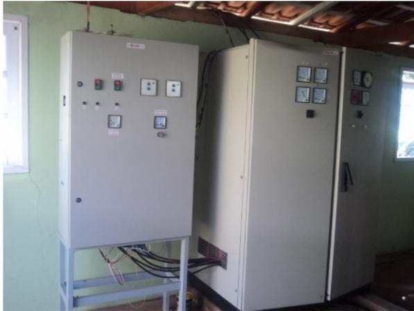
Figura 4.4: Quadro de força (direita) e quadro de controle e proteção (esquerda)
