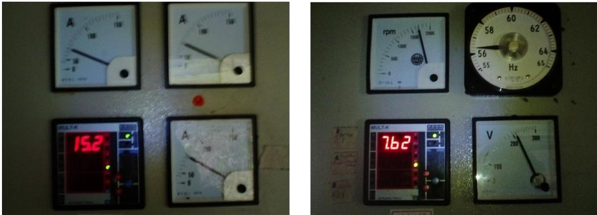
Figura 4.10: Medição elétrica. Esquerda: Medição do gerador, Direita: Medição da carga principal.
