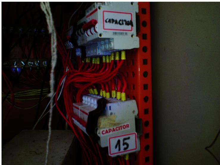
Figura 7.9: Chaves CH15 dos bancos de capacitores
