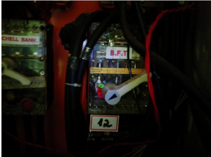
Figura 7.6: Chave CH12 que liga o gerador ao barramento de 200 V
