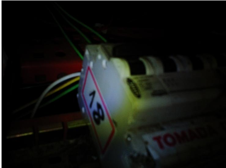
Figura 7.12: Chave CH18 que liga o primário do trafo isolador dos relés de sub e sobretensão respectivamente). Estes plugues são do tipo mostrado na Figura 7.14.
