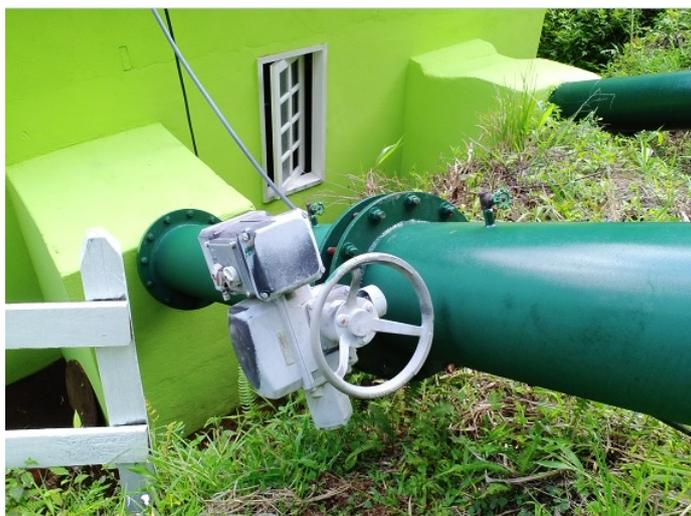
Figura 2.2: Válvula de admissão de água para a turbina
