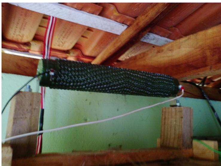
Figura 5.13: Resistor tubular do carregador de baterias
