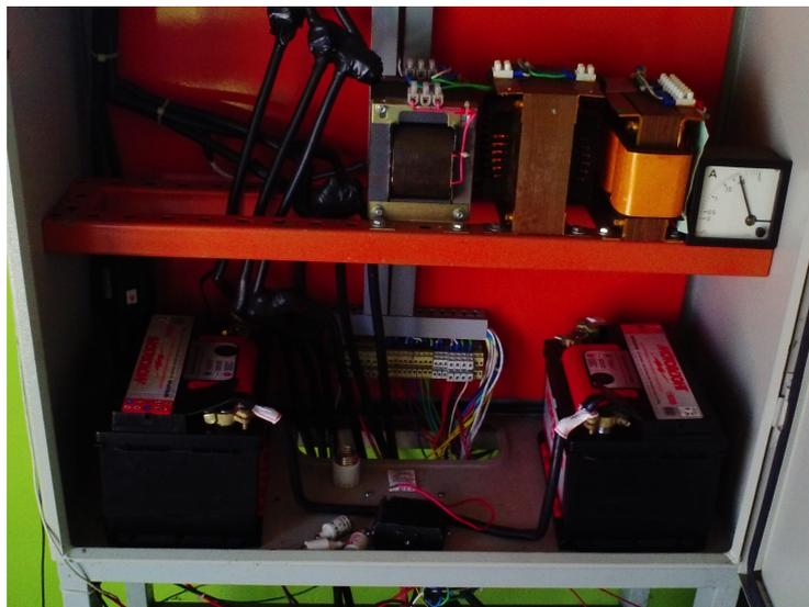
Figura 5.11: Transformador (centro) e amperímetro do carregador de baterias
