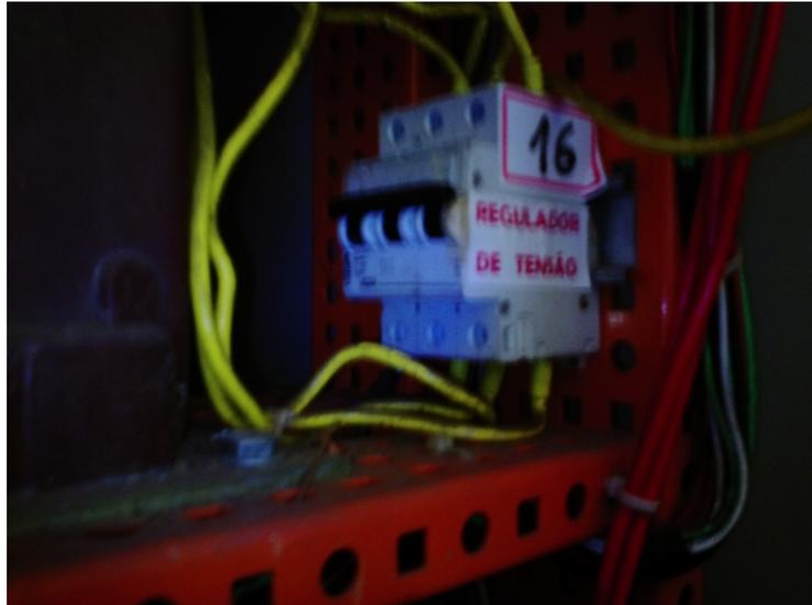
Figura 7.10: Chave CH16 que liga o transdutor de tensão
