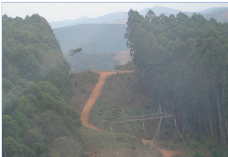
Figura 2.5 - Eucaliptos próximos a LT de 230 kV
