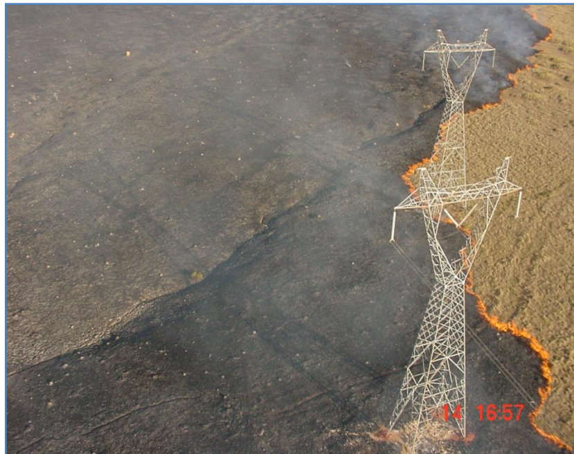
Figura 2.3 - Queimada próxima à Linha de Transmissão
