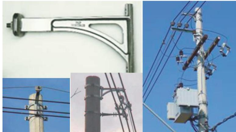
Figura Al.1 - Fotografias de braço tipo L utilizado nas redes compactas.
