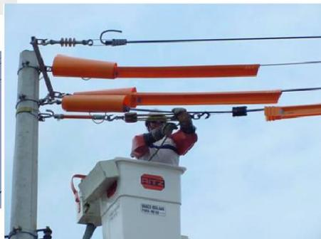
Figura A1.8 - Fotografias de grampo de ancoragem polimérico utilizado nas redes compactas.
