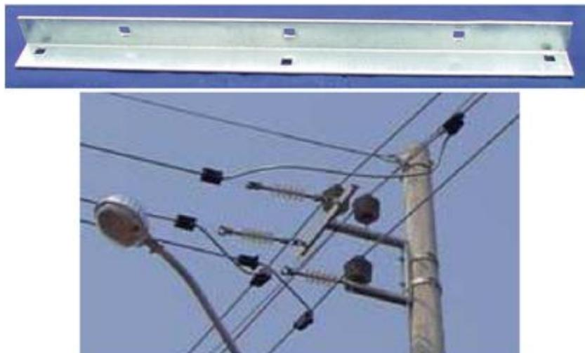
Figura AI.15 - Fotografias de cantoneira auxiliar utilizada nas redes compactas.
