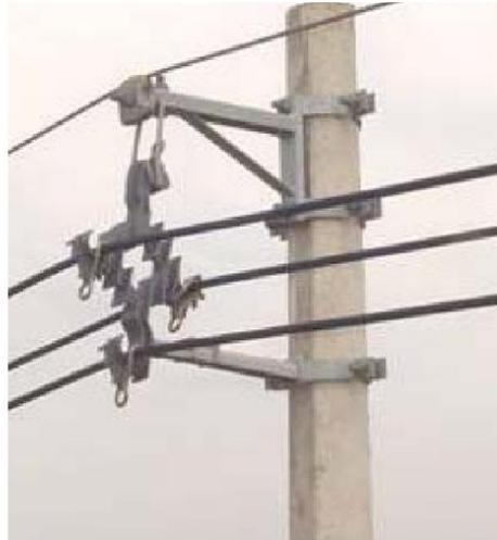
Figura A1.7 - Fotografias de braço anti-balanço utilizado nas redes compactas.
