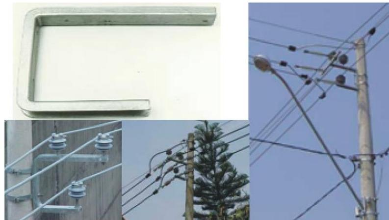
Figura Al.2 - Fotografias de braço tipo C utilizado nas redes compactas.
