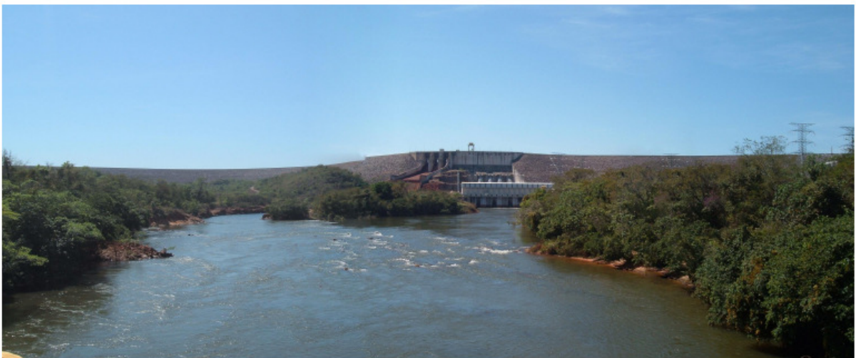
Figura 2-1 Vista a jusante da Barragem Aproveitamento Múltiplo Manso
