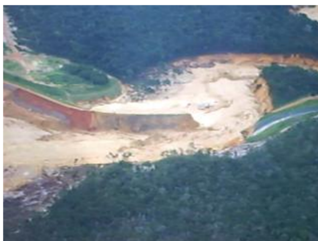
Figura 1-3 Rompimento de Barragem em Vilhena, Rondônia.
