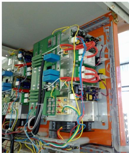
**Fig. IV.31- Circuito de potência - ponte inversora.**
