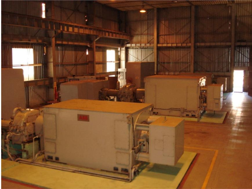
**Fig. I.2 - Turbo Geradores - Usina Sucro-Alcooleira.**
