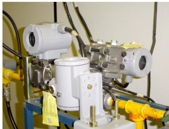
Figura 5.6 Medição de Vazão de Gás Combustível
