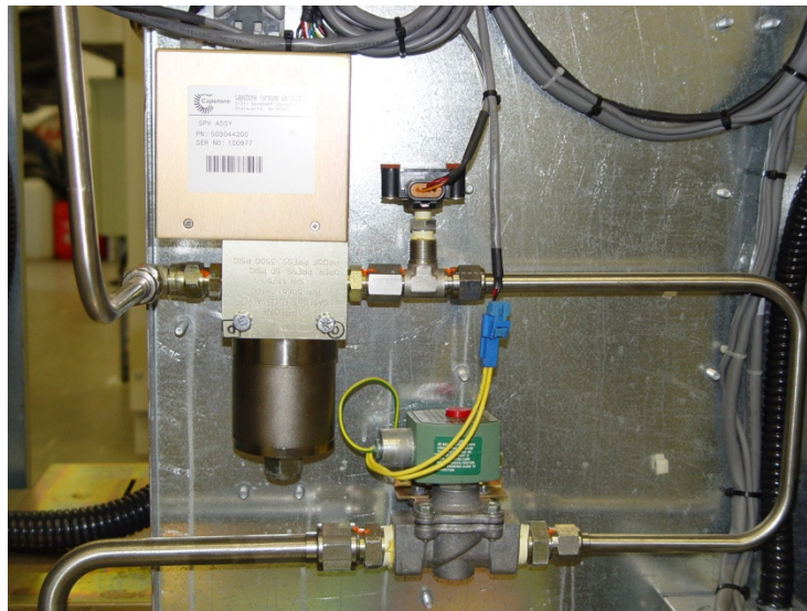
Figura 3.7 Válvula Reguladora, Sensor de Pressão e Válvula de Shut-Off
