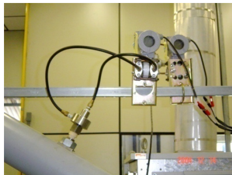
Figura 5.7 Medição de Vazão de Ar
