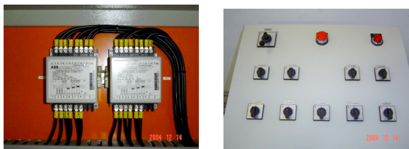
Figura 5.10 Medição de Potência Elétrica e Painel de Carga Isolada
