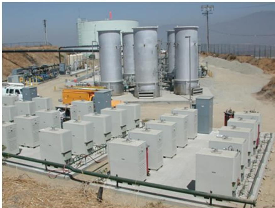
Figura 3.2 Usina com Micro-turbinas Operando em Paralelo
