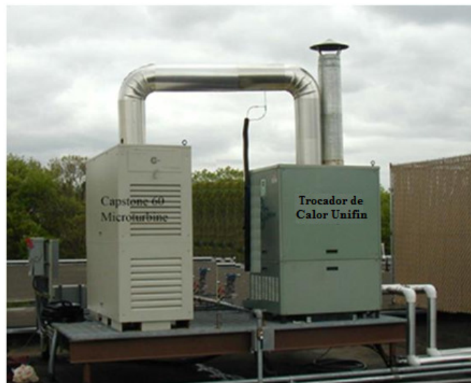
Figura 1.1 Sistema de Cogeração com Micro-turbina
