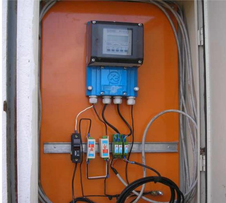
Figura 12 – Mostrador digital do medidor de vazão eletromagnético.
