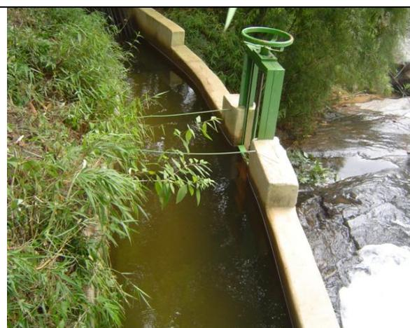
**Figura 3.2- Canal de adução e comporta desarenadora (fonte: Viana, 2008)**
