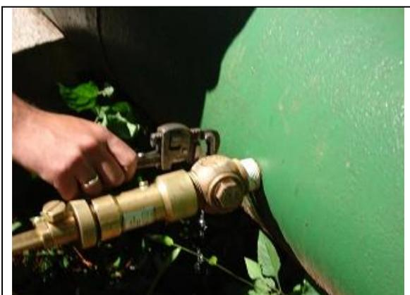
**FIGURA 3.16 – Taps para colocação de sondas de Pitot e Prandtl (fonte: Viana, 2008).**
