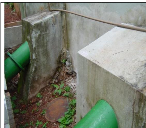
**FIGURA 3.3 – Câmara de carga e blocos de ancoragem (fonte: Viana, 2008)**
