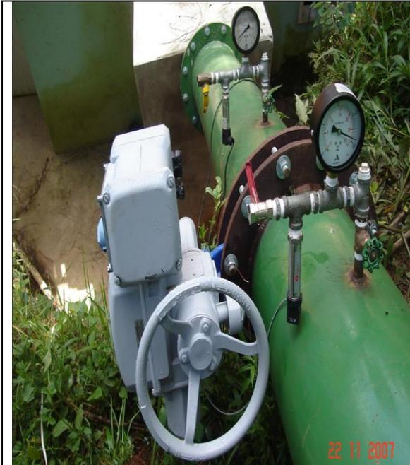
**FIGURA 4.2- Manômetros de pressão e transdutores instalados entre a válvula borboleta**
