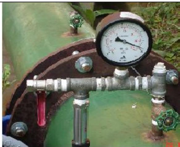
**FIGURA 3.15 – Tomadas de pressão no conduto forçado**
