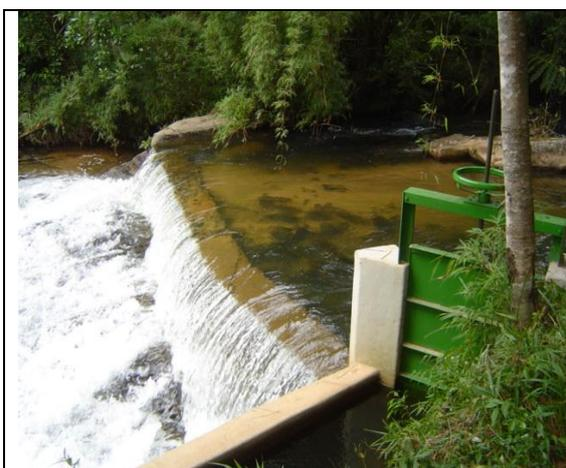
**FIGURA 3.1- Barragem e comporta da tomada d'água (fonte: Viana, 2008)**
