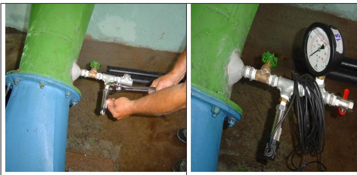
**FIGURA 4.2- Instalação dos medidores de pressão na entrada da TMB**
