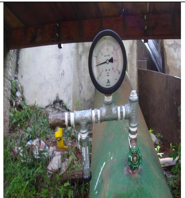
**FIGURA 4.5 - Manômetro de pressão e transdutor instalado antes da válvula borboleta**
