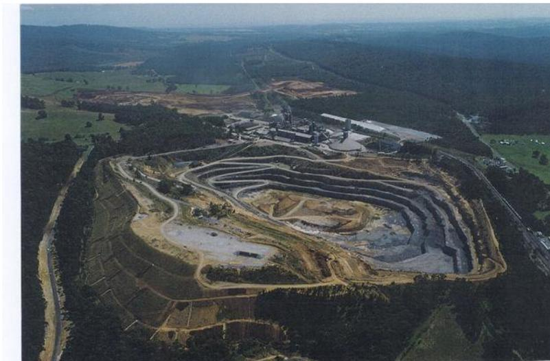
Figura 2.2 – Mina de calcário a céu aberto. No fundo a fábrica de cimento.
