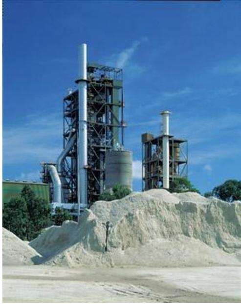
Figura 2.9 - Torre de 5 estágios com pré-aquecimento e pré-calcinador.
