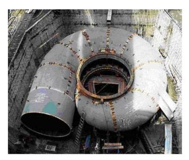
**Figura 6.1** Caixa espiral com pré-distribuidor de uma turbina Francis de eixo vertical (Granja Jiménez, 2004).
