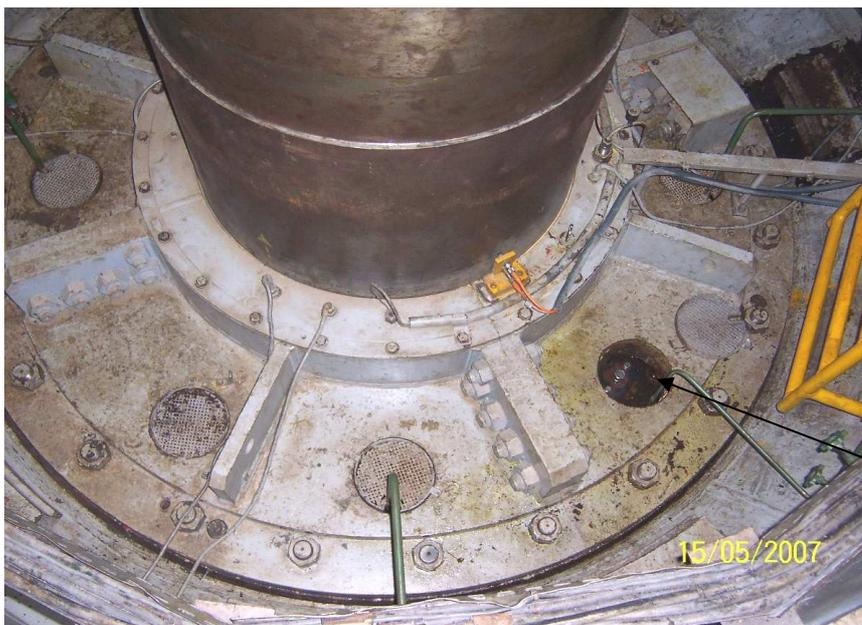
Escotilha para observar fluxo de água no poço da turbina
