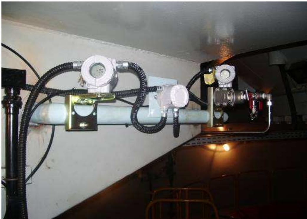
Figura 3.13 - Transmissores conectados na máquina. (a) Transmissor da direita: pressão água de vedação. (b) Transmissor à esquerda: nível de água no poço de drenagem da turbina.
