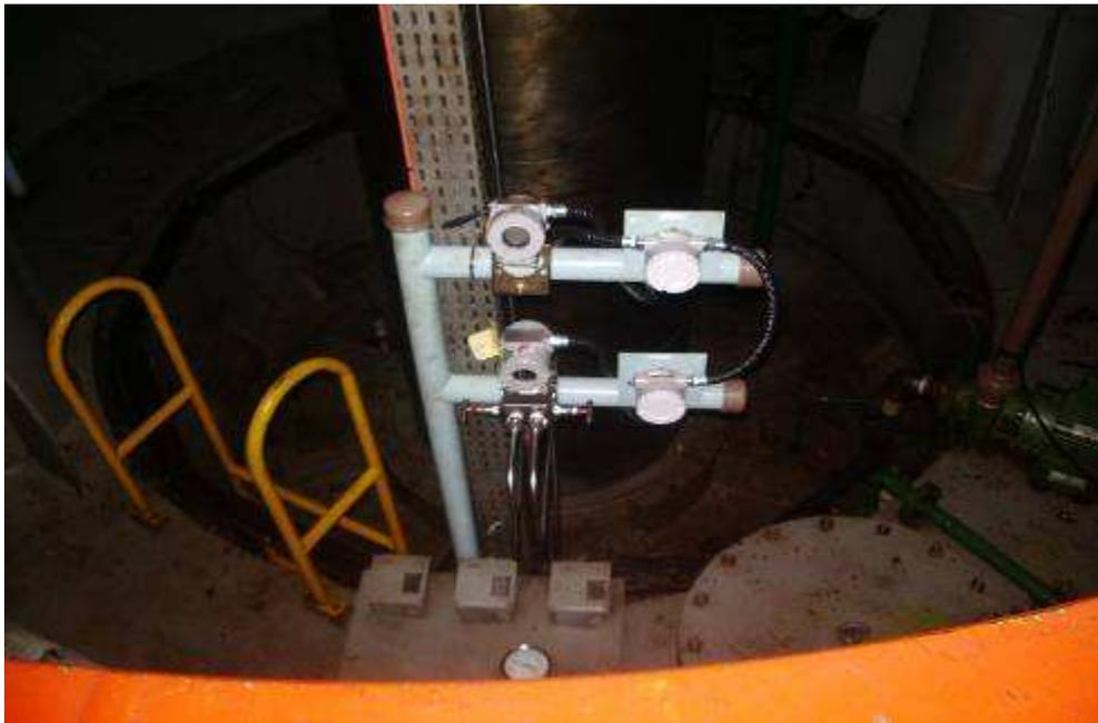
Figura 3.11 - Transmissores conectados na máquina. (a) Transmissor superior de temperatura da água do poço de drenagem da turbina. (b) Transmissor inferior: pressão diferencial.
