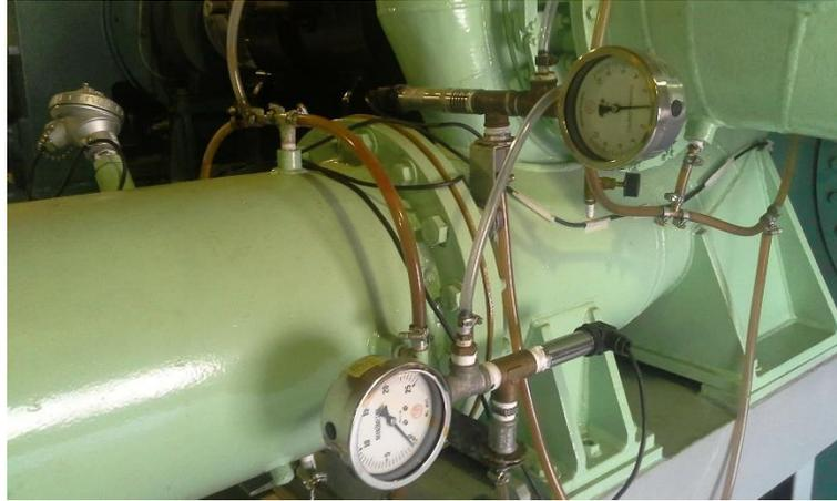
**Figura 5.8** – Medidor de Pressão entrada da Turbina
