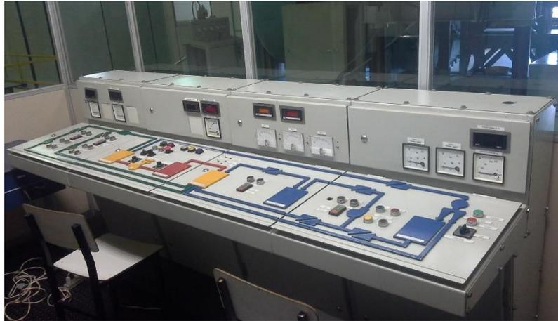
**Figura 5.10** – Painel de Controle Medição de rotação da Turbina
