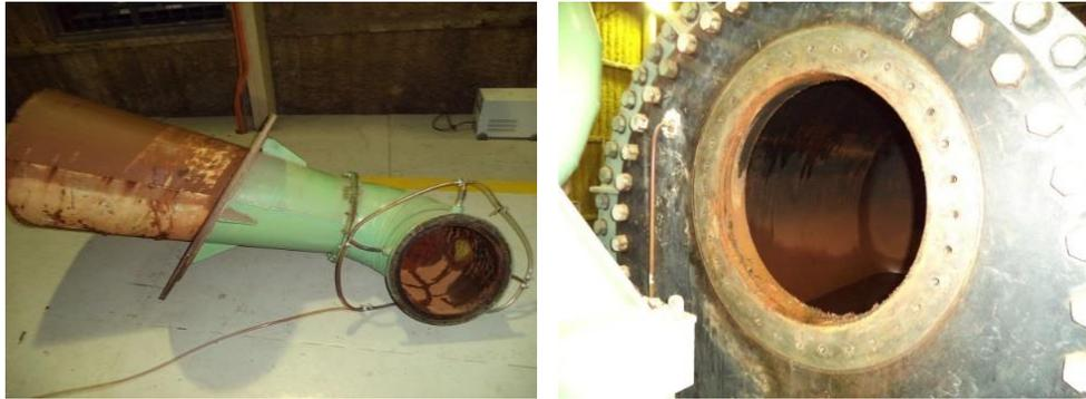
**Figura 5.13** Reparo no tubo de sucção e no tanque montante.
