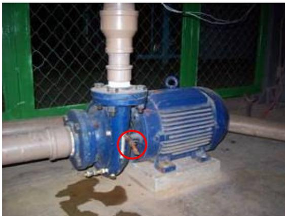
Figura 40 – Orifício para inserção de bolhas na tubulação (destaque)
