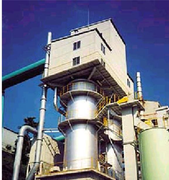
Figura 4.9 – Fotografia de um forno vertical mecanizado de produção de clínquer (IECC, 2006).
