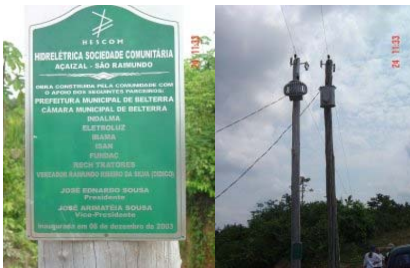
FIG.14 – PLACA INAUGURAÇÃO e TRANSFORMADORES
