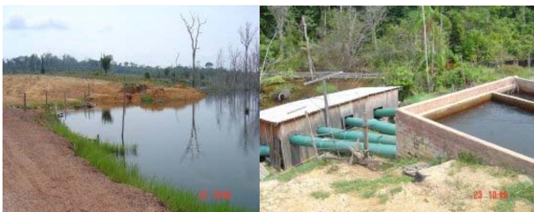
FIG. 9 – BARRAGEM E CASA DE FORÇA DA USINA DE SÃO JORGE
