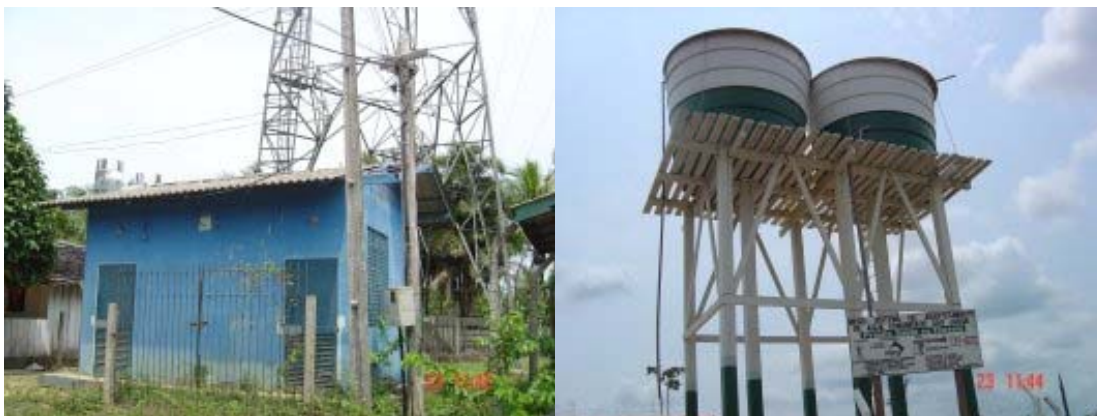
FIG. 11– TORRE DE TELEFONIA DA TELEMAR e SIST. DE ABASTEC. DE ÁGUA
