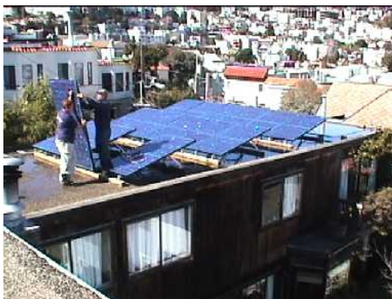
FIGURA 5 - Sistema fotovoltaico interligado à rede elétrica
