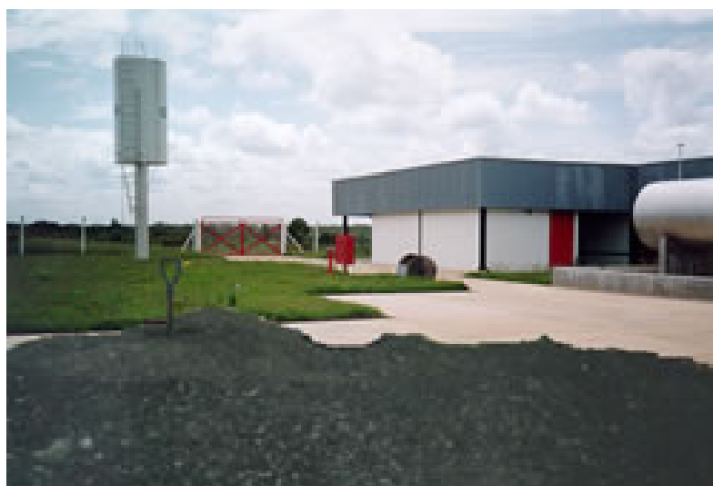
FIGURA 10 - Gaseificador de carvão – Usina de Formoso
