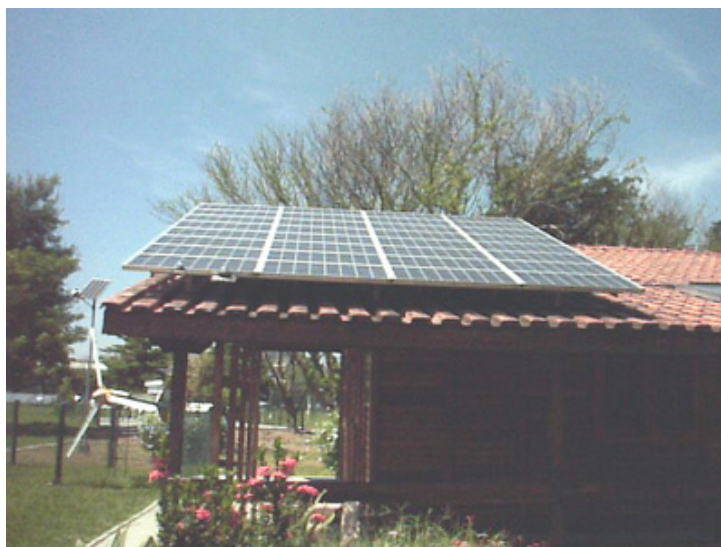
FIGURA 6 - Sistema fotovoltaico fixo
