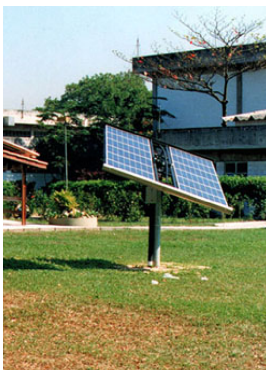
FIGURA 7 - Sistema fotovoltaico com rastreador solar
