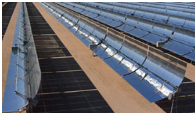
FIGURA 8 - Concentradores cilíndrico-parabólicos
