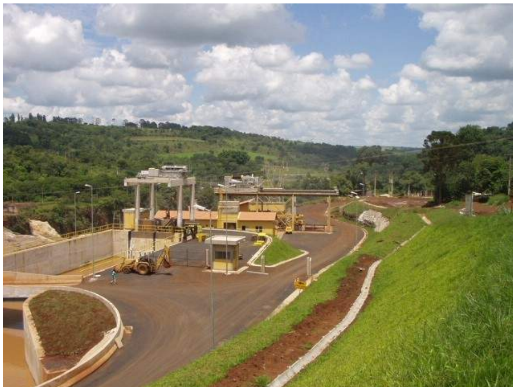
FIGURA 3 - Vista geral da PCH Pai Joaquim - CEMIG
