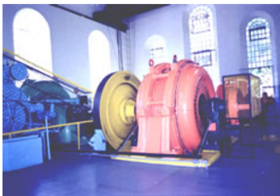
FIGURA 17 - Gerador Elétrico da Usina Luiz Dias (PCH)
