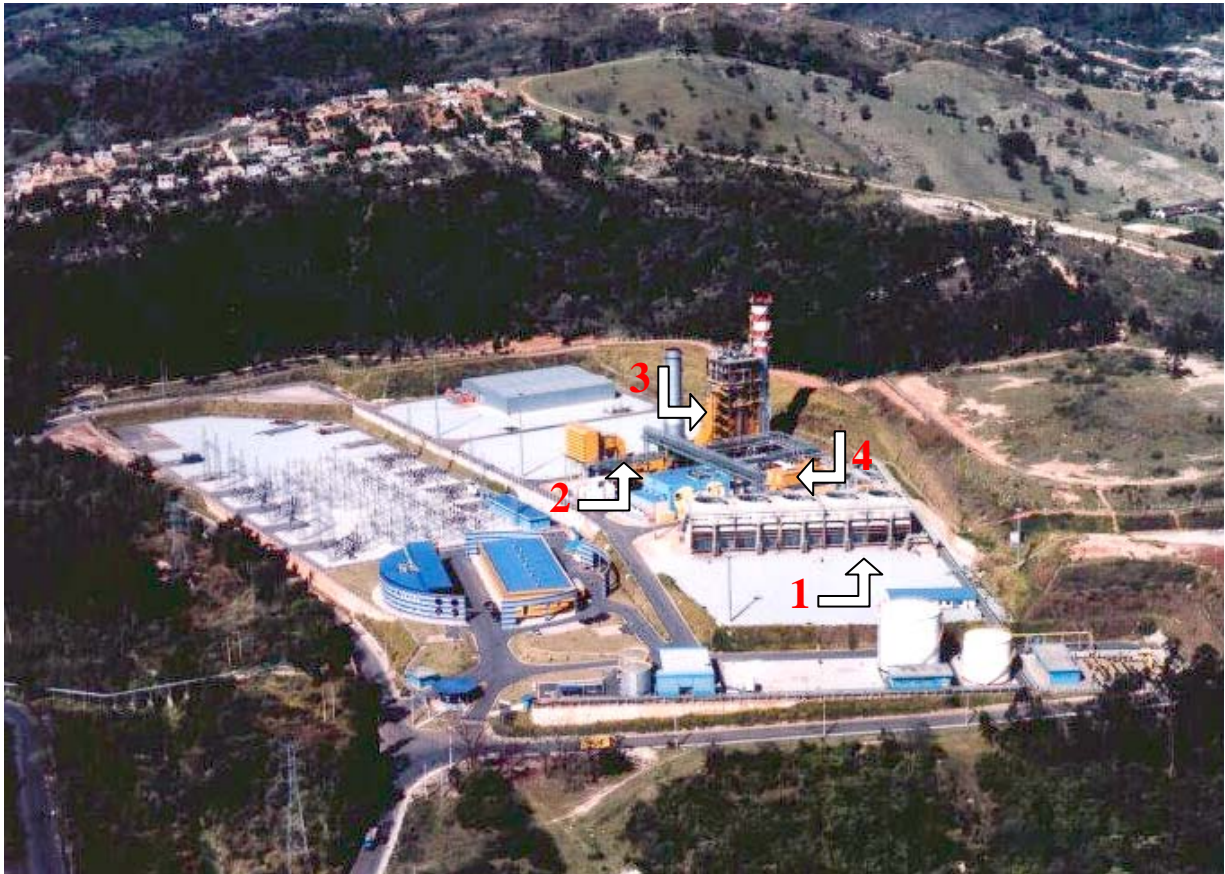
Figura 3.1: Vista aérea da usina Ibiritermo. (1) Torres de Resfriamento; (2) Turbina a Gás; (3) Caldeira Recuperativa de Calor; (4) Turbina a Vapor.
