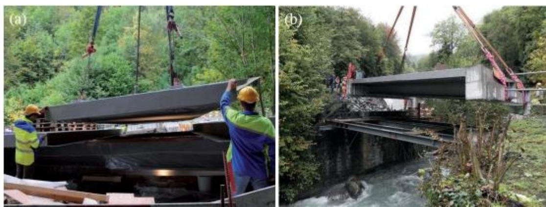
Figura 2.11 – Tabuleiro da ponte sobre o Rio *Avançon* próximo a Bex, na Suíça. a) Montagem dos componentes do tabuleiro. b) Posicionamento do tabuleiro. Fonte: Keller *et al.* (2014), *apud* Garrido (2016).
