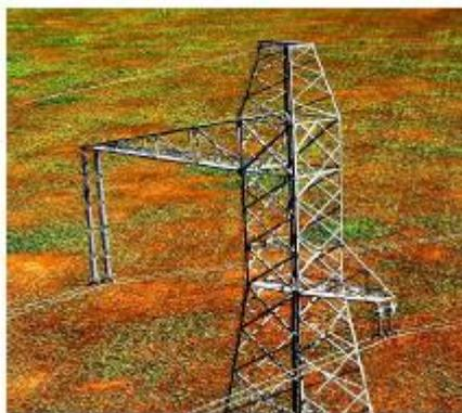
Figura 19: Torre de elo monopolar (retorno "metálico"), elo do sistema. Basslink, 400 KV DC.
