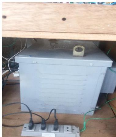
Figura 37: Transformador do lado do inversor
