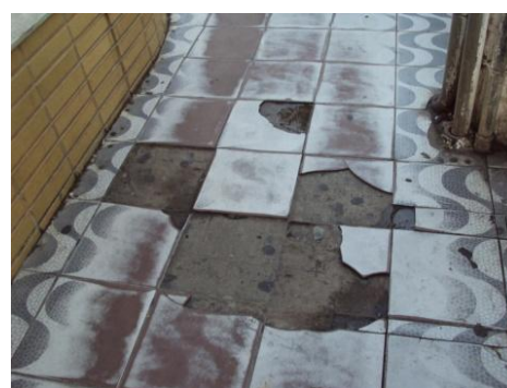
(b) Piso escorregadio e danificado
