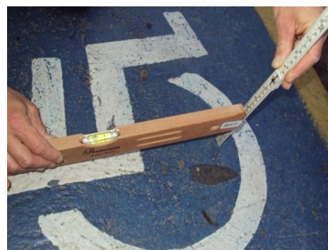
(b) Rampa oposta com inclinação superior ao permitido
