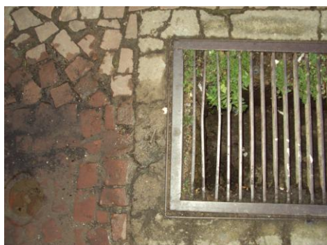
(a) Grelha no fluxo de pedestres e com vãos fora do estabelecido
