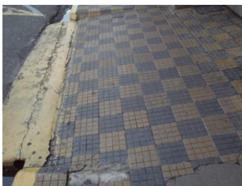
Figura 16: Desnível no piso em entrada de garagem
