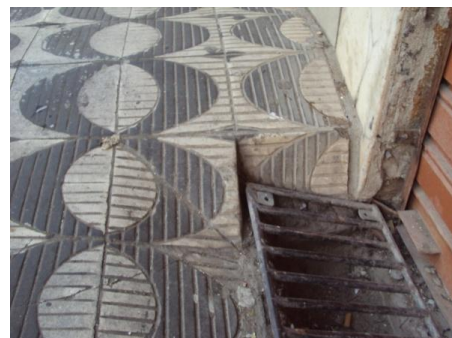
(b) Degrau sem sinalização
