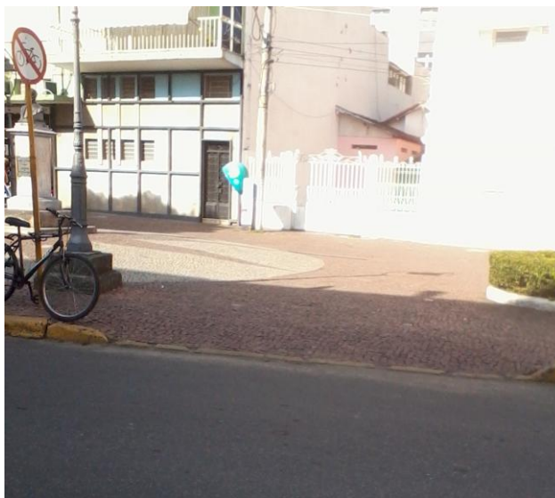
Figura 33: Rebaixamento não sinalizado no Trecho D
