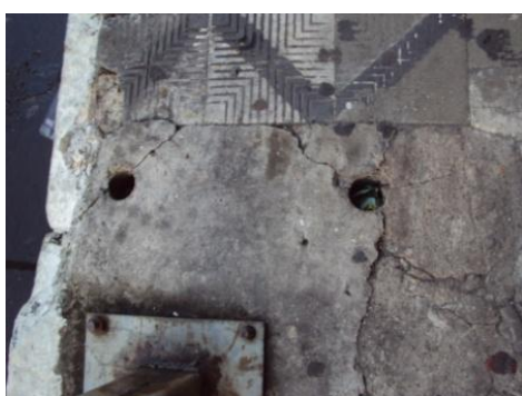
(a) Avarias e buracos no piso
