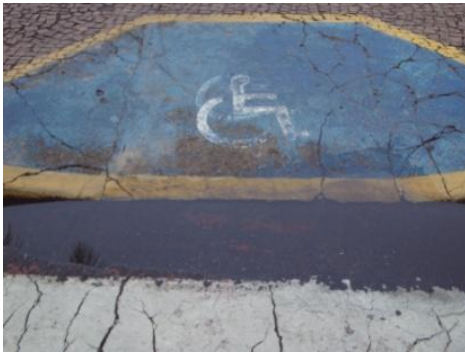
(a) Poça d'água na rampa
