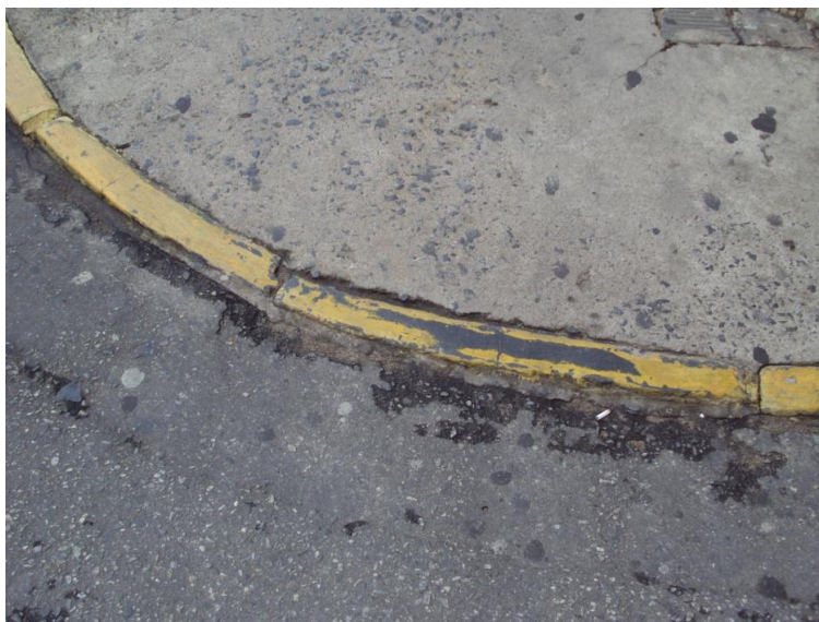
Figura 10: Rampa de Travessia
