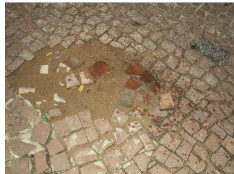
(b) Piso mal assentado
