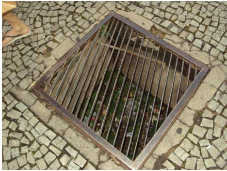
(a) Grelha com vãos acima do permitido
