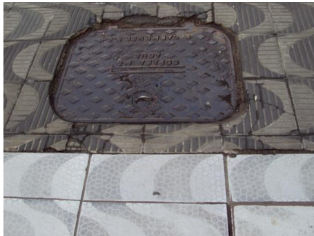
(a) Caixas de Visita e Inspeção sem nivelamento
