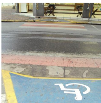
(a) Rampa de saída do Calçadão ocupa toda a calçada
