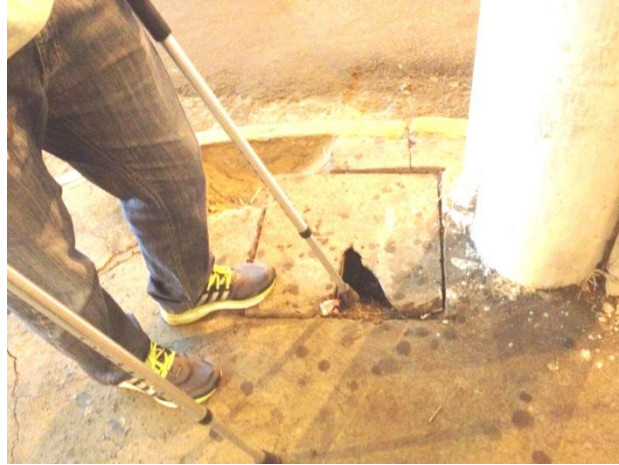
Figura 31: Buraco no piso no Trecho B
