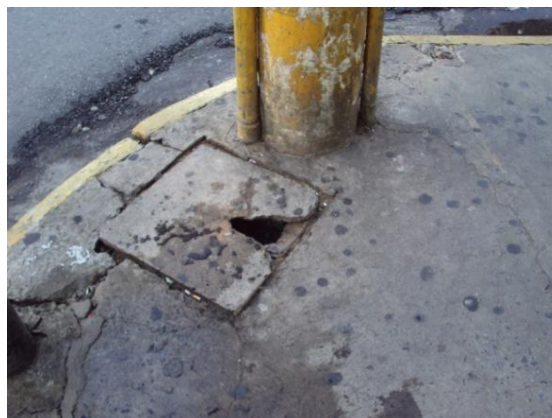
Figura 13: Buraco no piso
