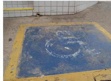
(b) Rampa invade a calçada
