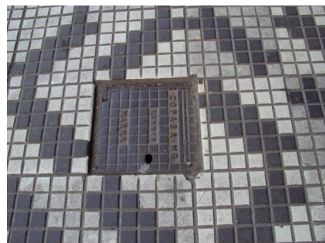
(b) Caixas de Inspeção não niveladas ao piso
