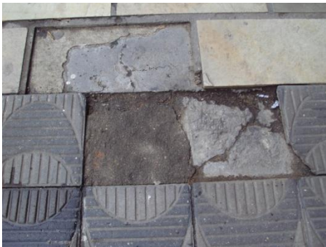
(a) Desnível provocado por avarias
