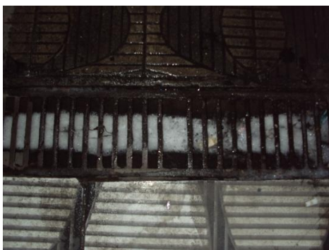
(a) Grelha com vão alargado
