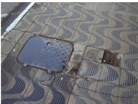
(a) Caixa de Inspeção não nivelada com o piso
