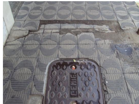
(b) Desnível provocado por caixas de inspeção
