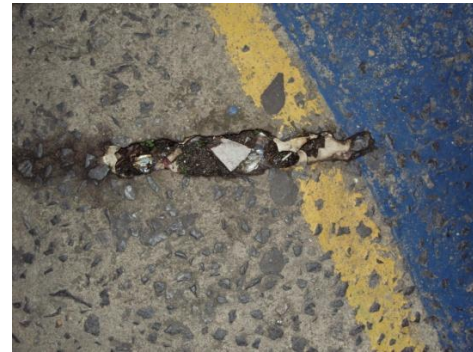
(b) Buracos na rampa
