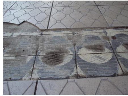
(b) Piso não nivelado
