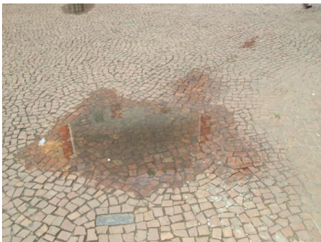
(a) Depressões no piso
