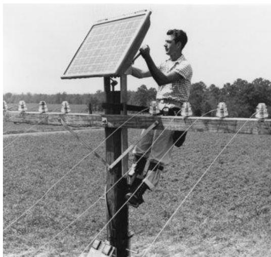
Figura 3 – A primeira aplicação de uma célula solar de silício em uma rede de telefonia (NJ, 2010).
