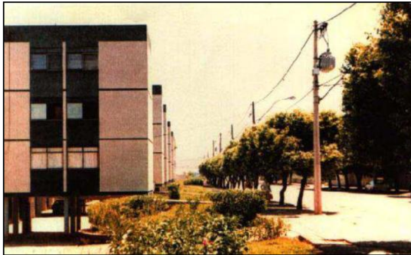
Figura 2.4: : Rede de distribuição aérea isolada.
