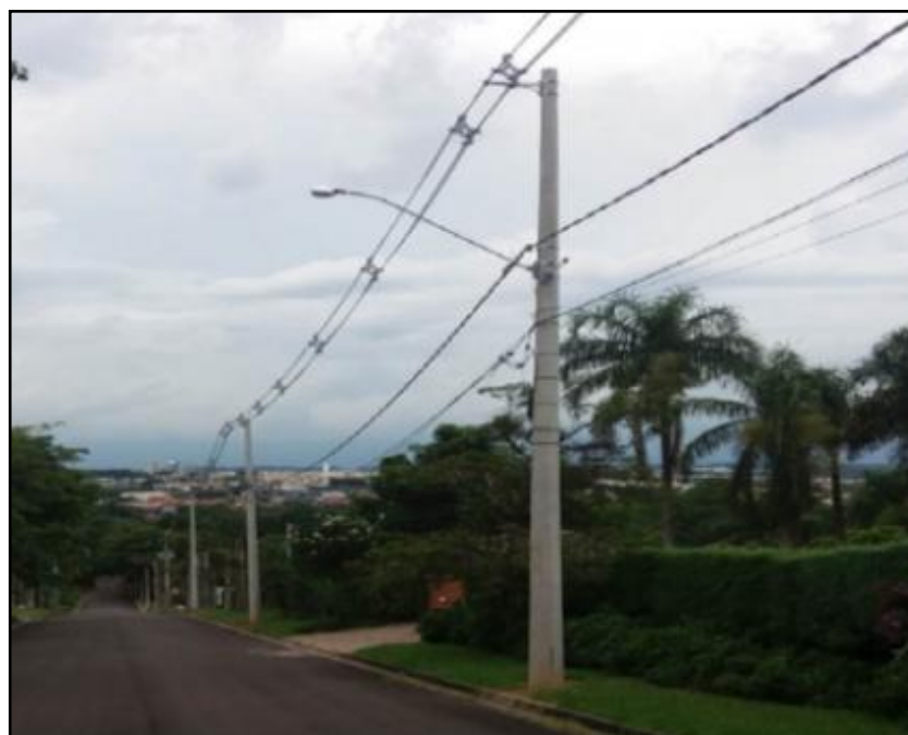
Figura 2.3: Rede de distribuição compacta.
