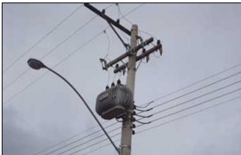
Figura 2.2: Rede de distribuição convencional.
