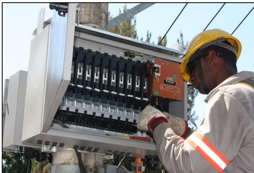
Figura 2.16: Tecnologia antifurto - Conjunto de medição inteligente tipo SIN-NANSEN. Fonte: (NANSEN, 2017).
