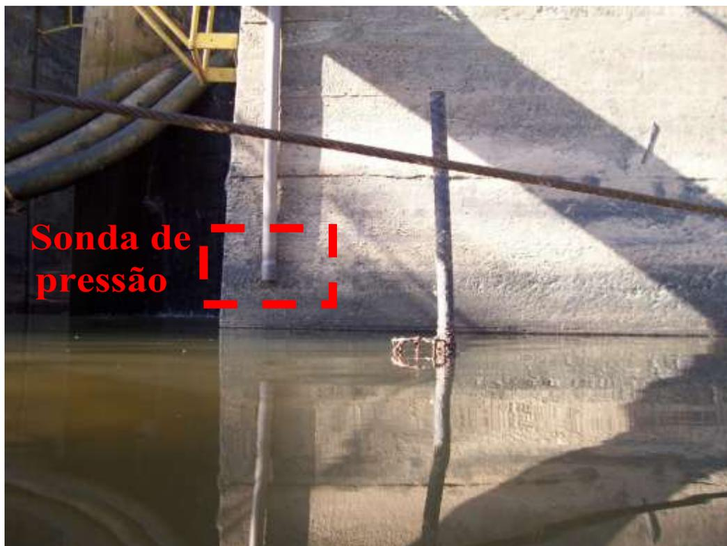
Figura 3.13 – Sonda de pressão instalada.
