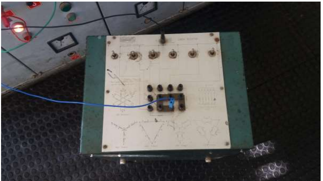
Foto 6: Banco de resistências de frenagem
