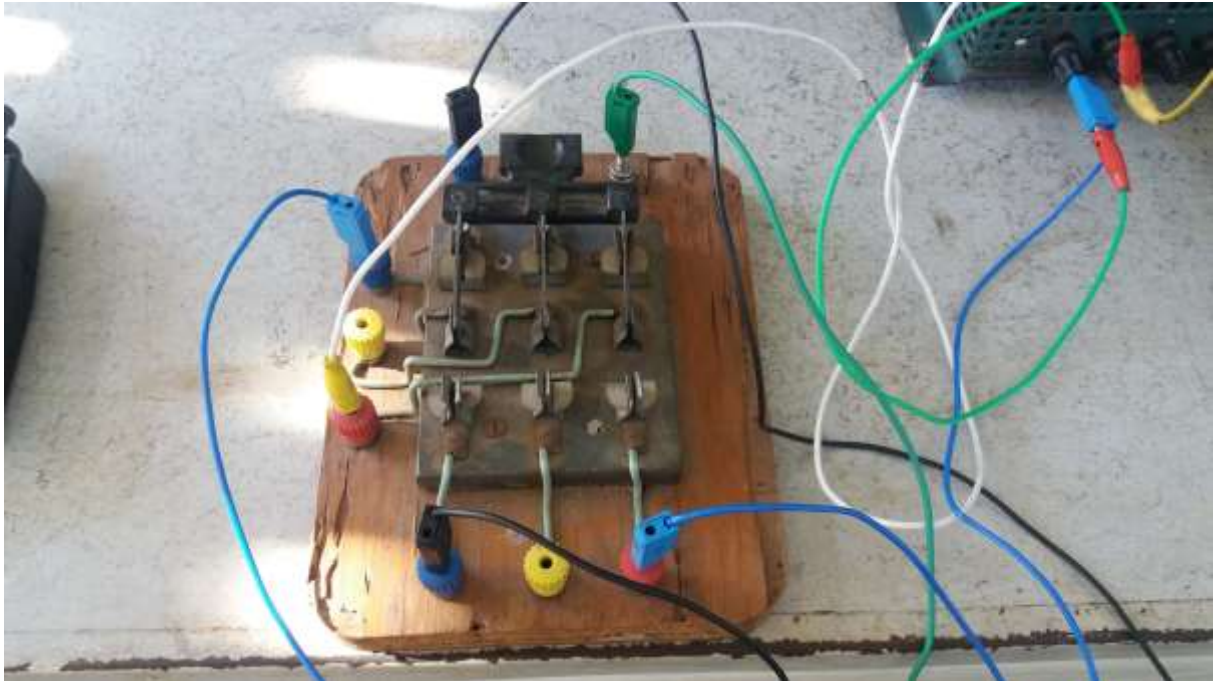
Foto 3: Chave reversor da operação da máquina de motor para gerador
