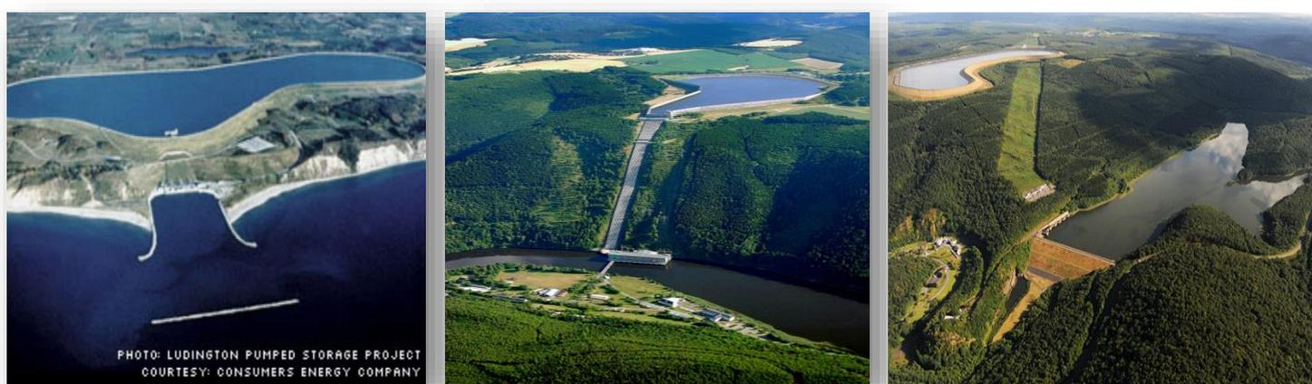
Figura 11 – Projeto da UHR Ludington, nos Estados Unidos, de circuito aberto (à esquerda); UHR Goldisthal, na Alemanha, de circuito semi-aberto (centro) e UHR Limberg II, na Áustria, de circuito fechado (à direita). (FONTE: TIAGO FILHO, 2016)
