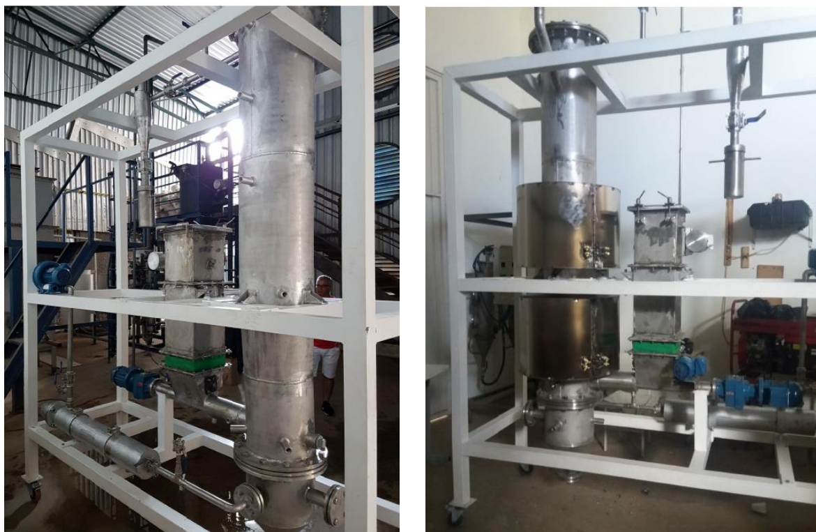
Figura 41 – GLFB construído (sem isolamento térmico)
