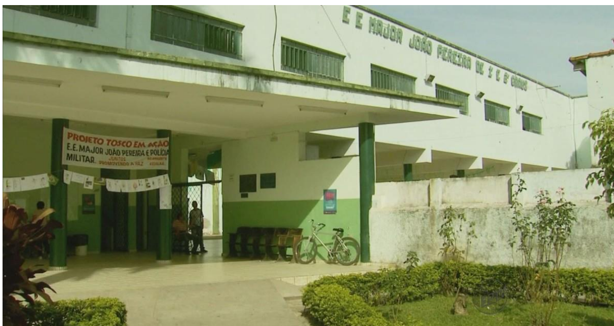
Figura 10: Fachada da Escola Major João Pereira
