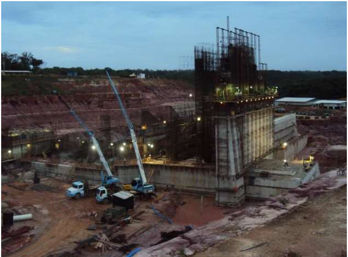
Figura 4 – Construção da PCH Telegráfica no rio Juruena – MT. Fonte: Próprio autor.
