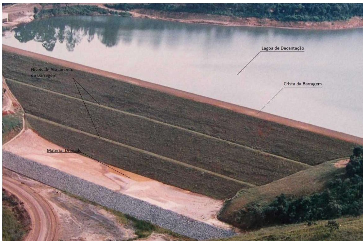
Figura 3 – Barragem Casa de Pedra - Contenção de rejeito de mineração. (modificada) Fonte: http://dam.com.br/index.php/pt-br/barragens-contencao
