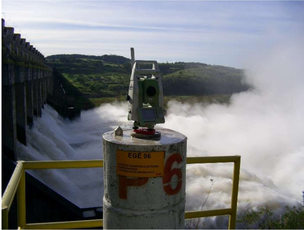
Figura 19 – Estação total robotizada, monitorando uma barragem hidrelétrica. Fonte: NADAL (2017)
