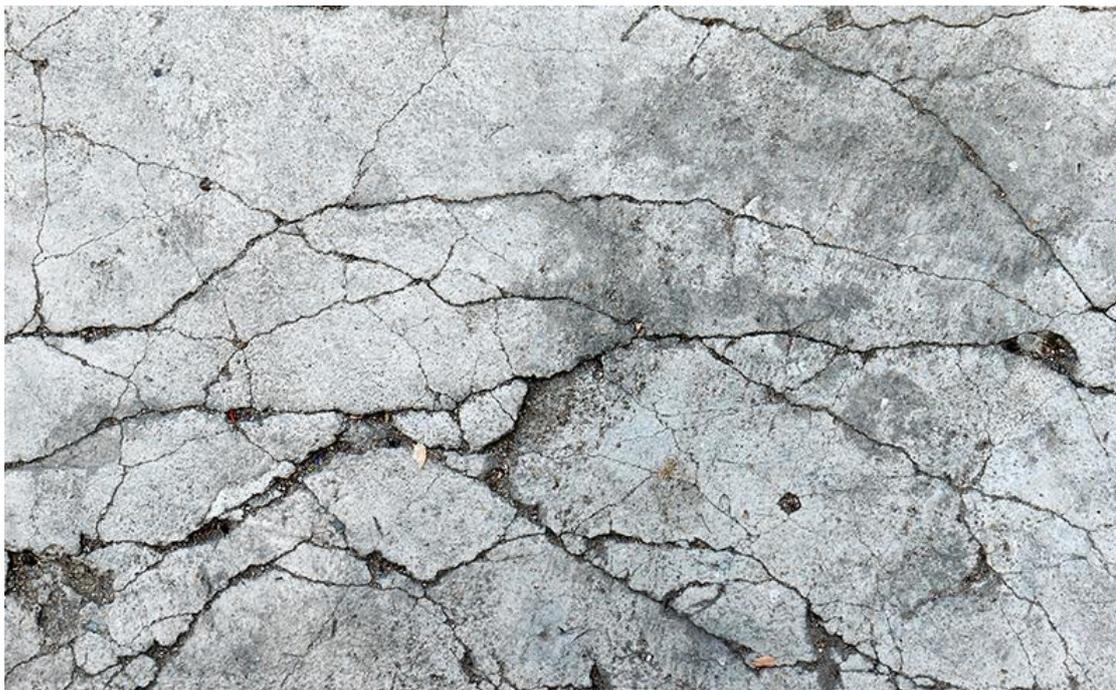
Figura 2.20 – Fissuras em uma estrutura de concreto originária da reação álcali-agregado.
