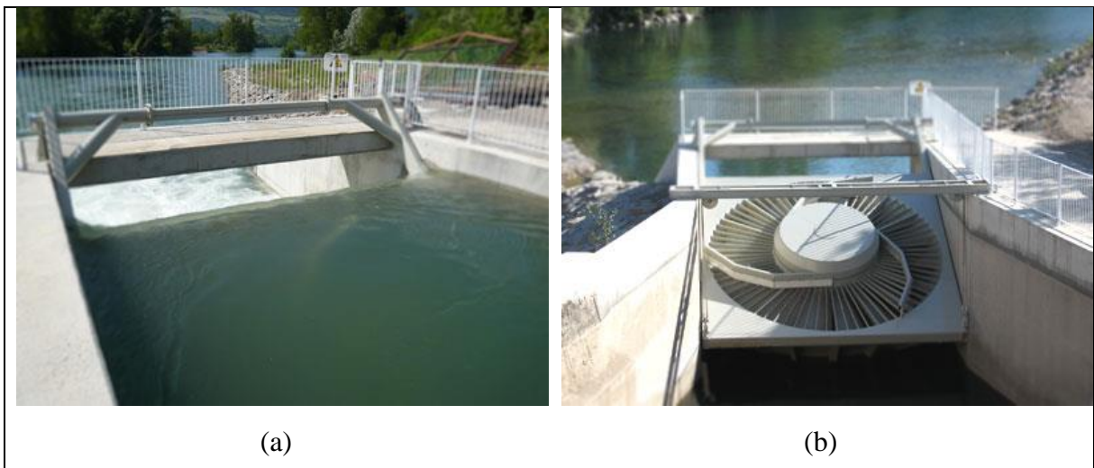
Figura 2.6. Instalação da VLH
