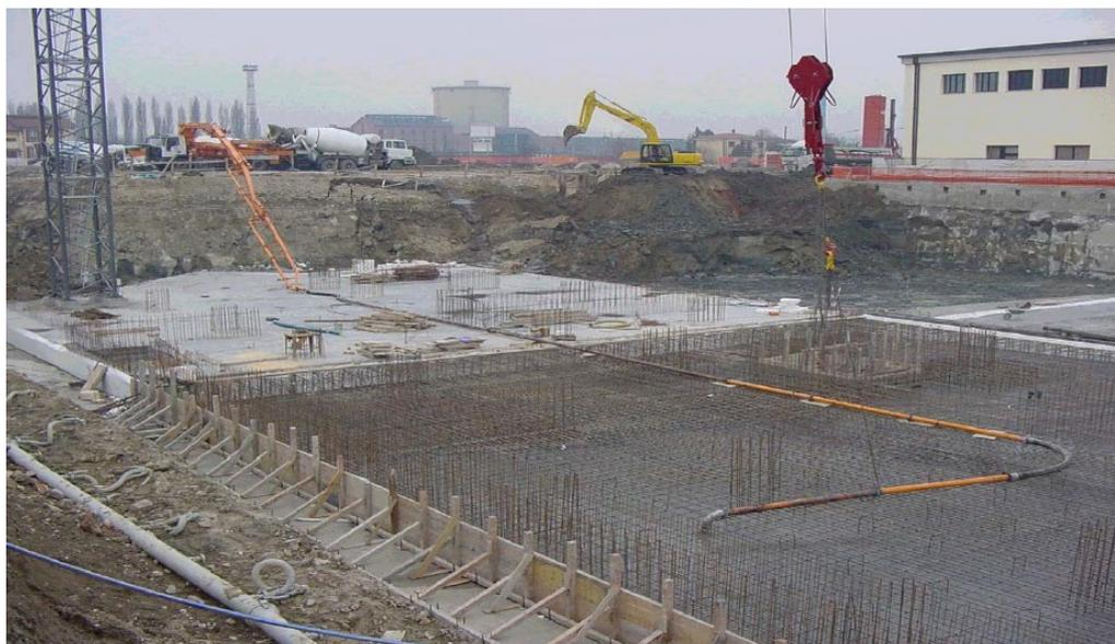
Figura 7: Concretagem de laje no Centro Comercial em Ferrara, Itália (Fonte: EFNARC, 2002).
