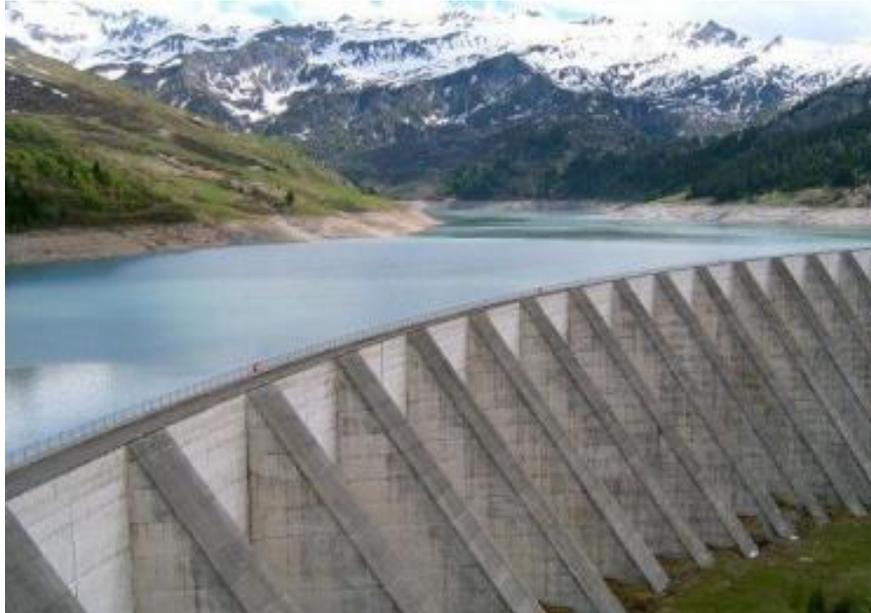
**Figura 8** – Barragem de Concreto com contraforte em Roselend - França
