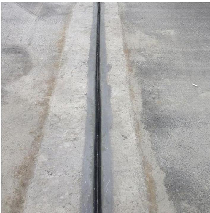
**Figura 10** – Junta de dilatação.
