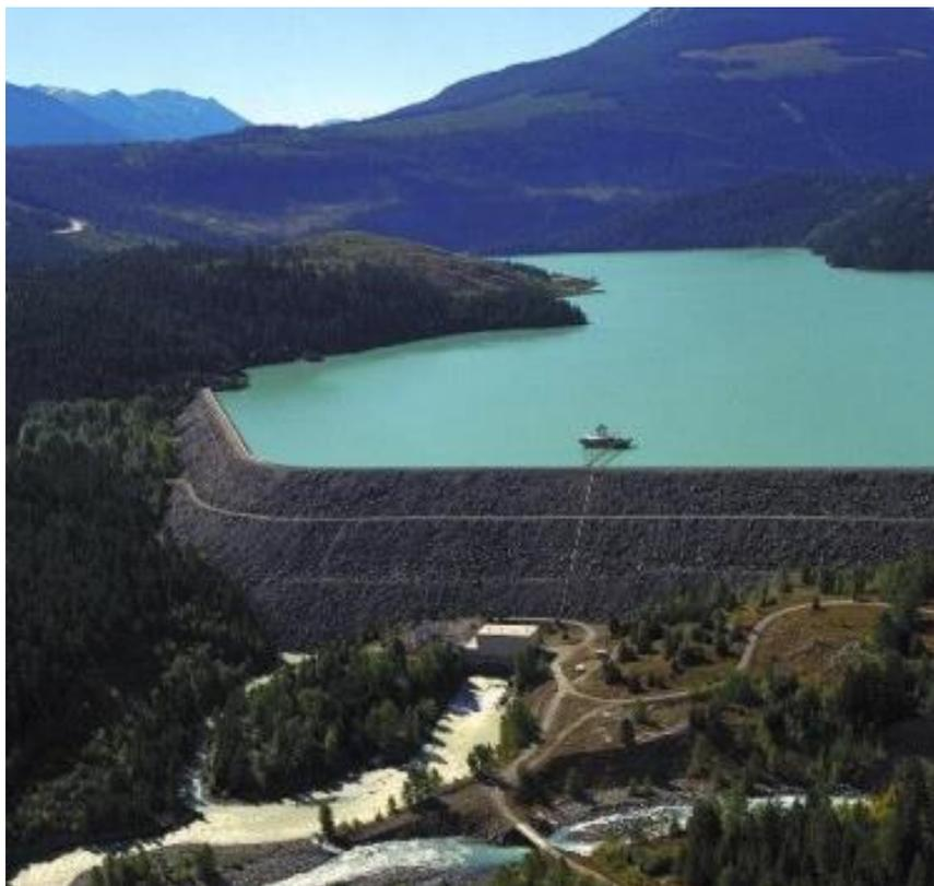
**Figura 9** – Barragem de Terra em Lajoie - Canadá
