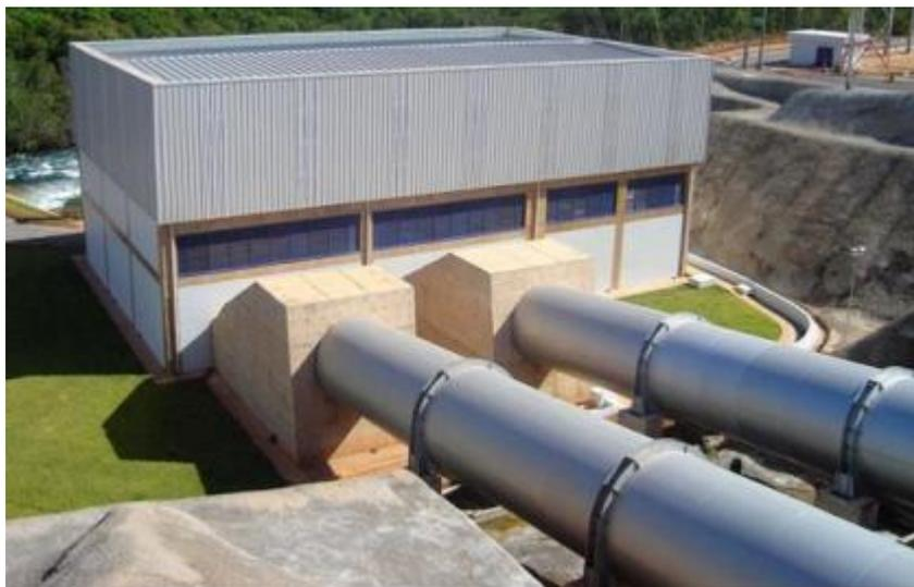
**Figura 31** – Conduto Forçado – PCH Garganta da Jararaca – Rio Sangue / MT
