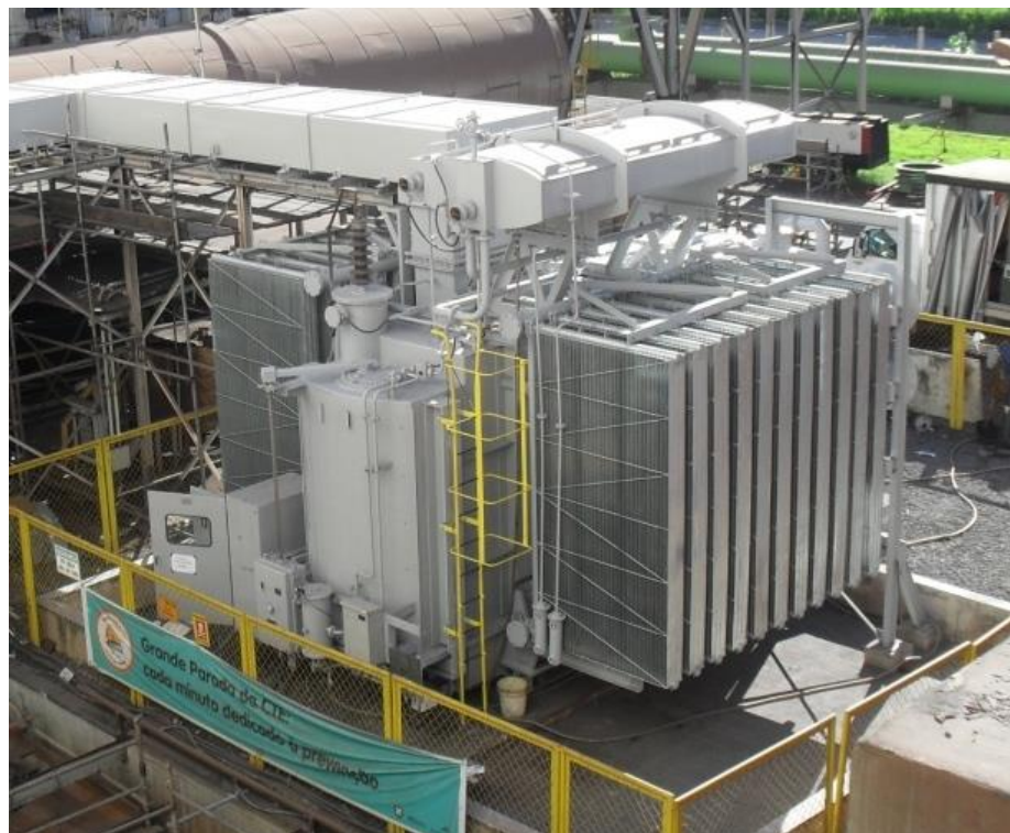
Figura 2.1 – Transformador elétrico de potência instalado em usina siderúrgica Fonte: Autor
