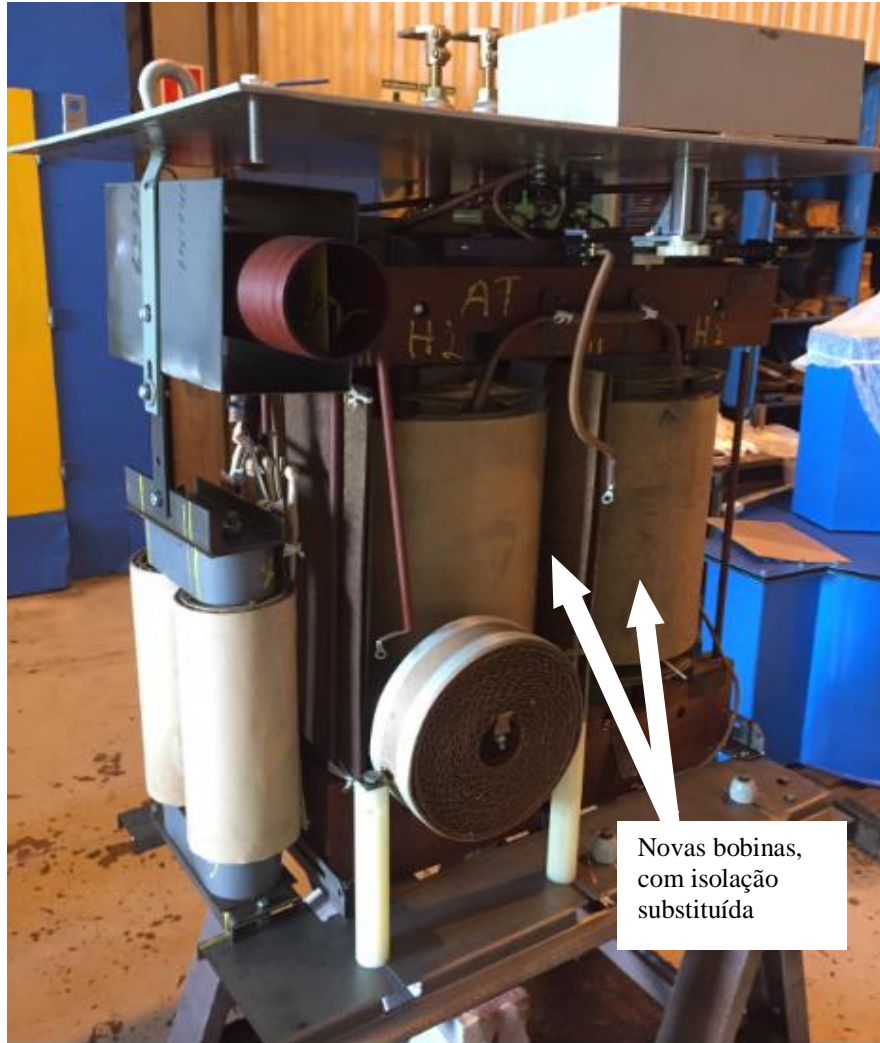
Figura 5.14 – Ação corretiva de rebobinamento em transformador retificador Fonte: Autor
