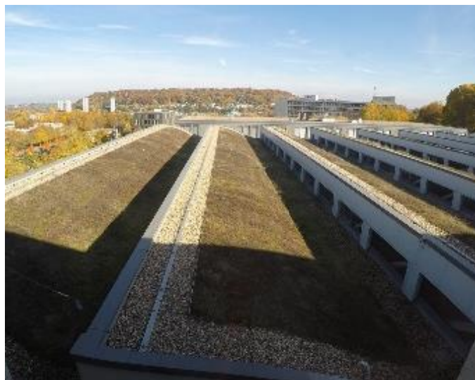
Figura 2.15 – Telhado Verde em Aachen, Alemanha Fonte: Autora
