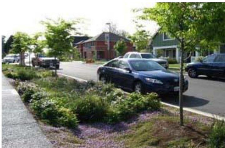
Figura 2.12 - Vala de Infiltração Fonte: EPA (2019)
