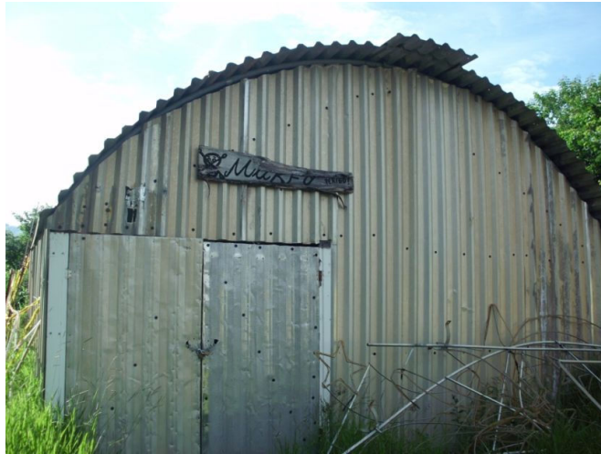
Figura 4.6. Parte externa do galpão
