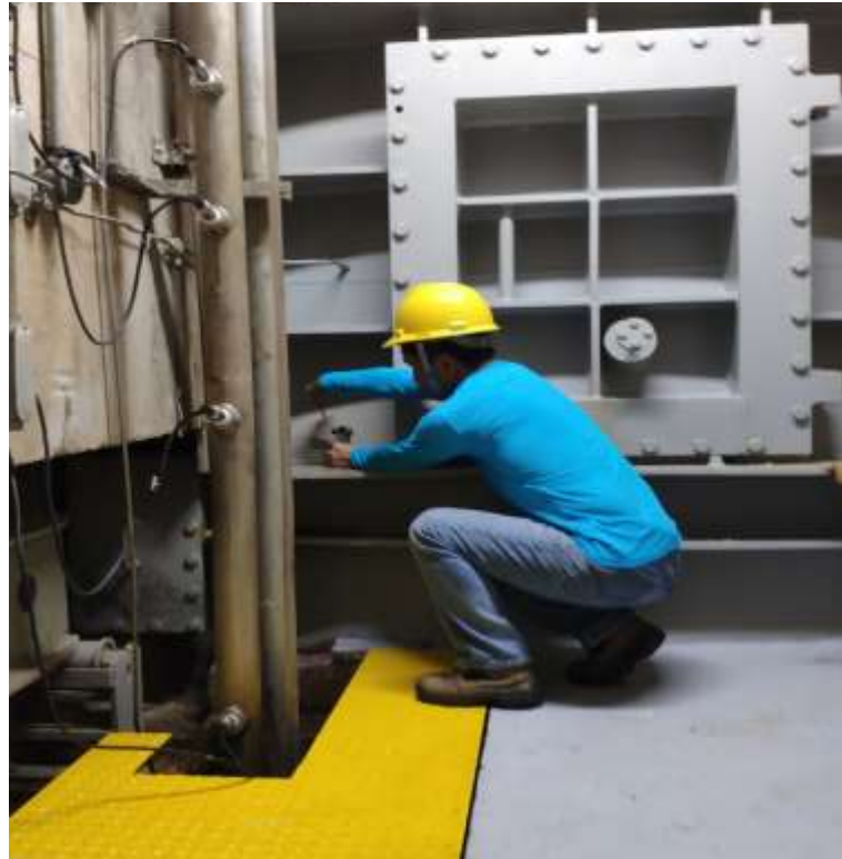
Figura 42: Coleta de amostra de água no tubo de sucção da usina Cana Brava Fonte: acervo do autor (2020)
