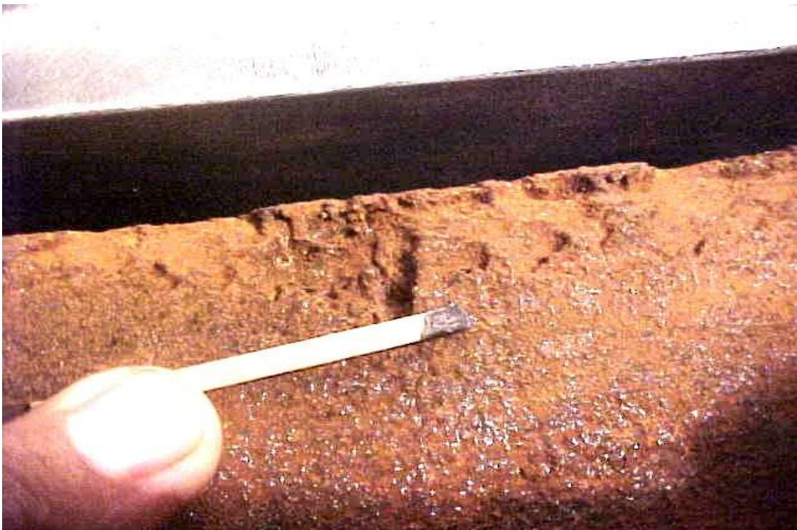
Figura 70: Erosão no aro de saída comparado ao palito de fósforo
