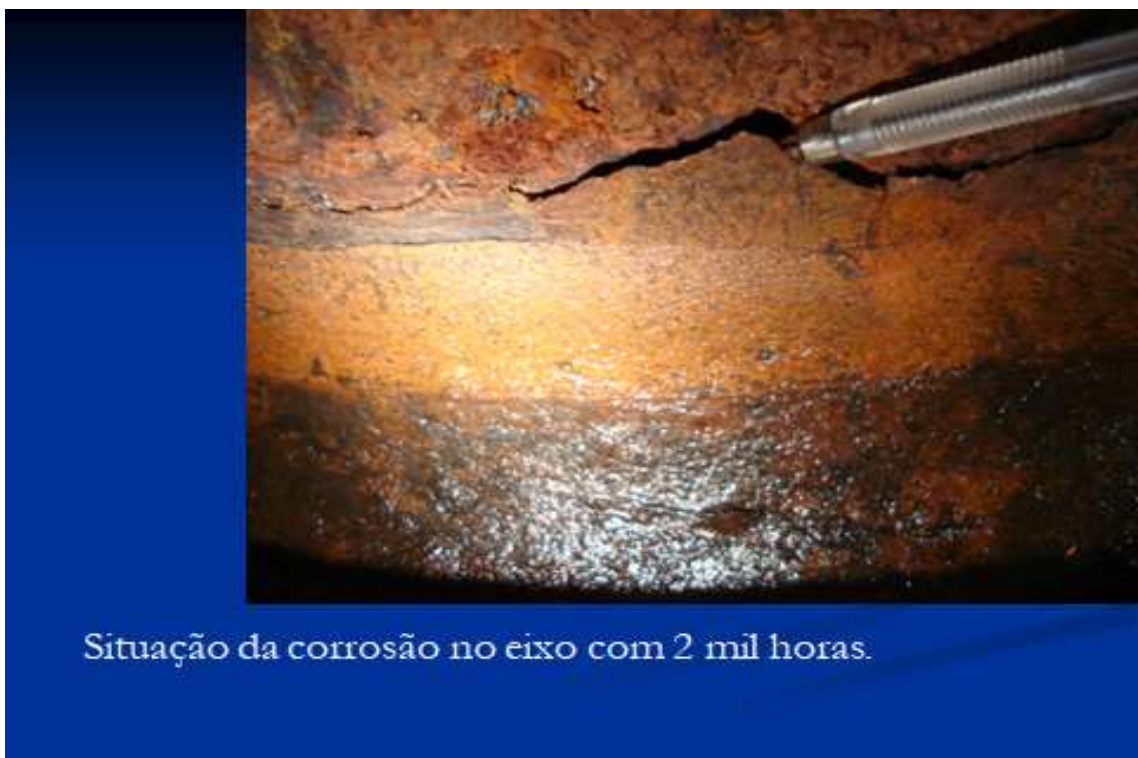
Figura 56: Detalhe da corrosão em forma laminar.
