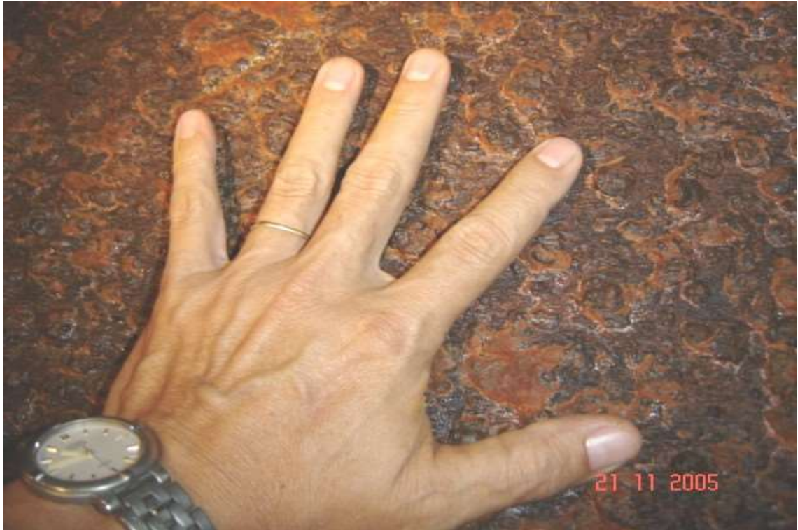
Figura 21: Superfície interna de conduto forçado coberto por tubérculos Fonte: acervo do autor (2005)
