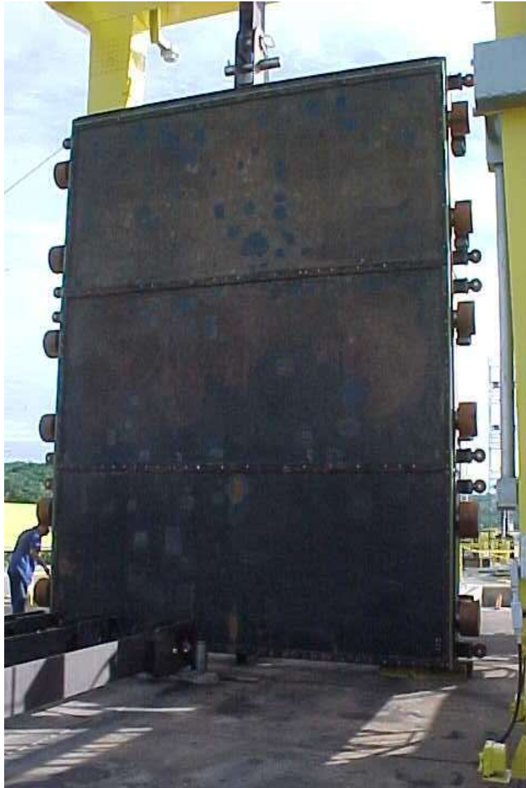
Figura 71: Comporta vagão inspeção após 1.240 horas de operação
