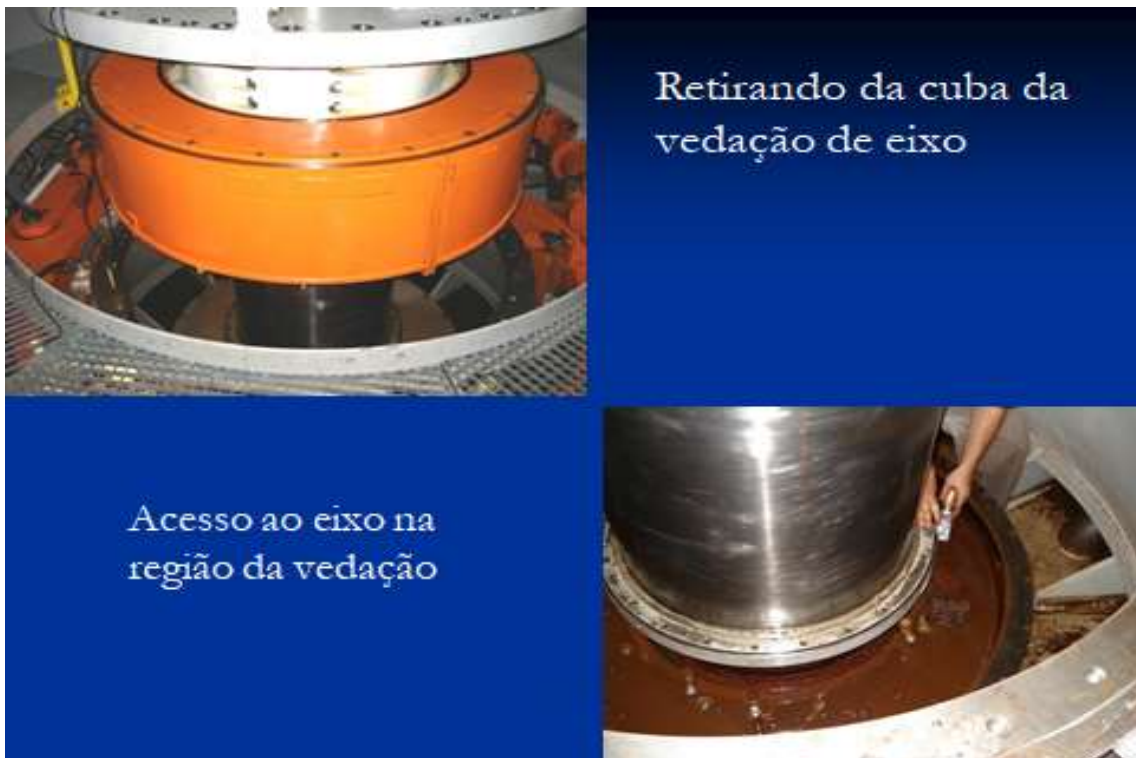
Figura 52: Desmontagem para inspeção da cuba de alojamento da vedação de eixo de turbina
