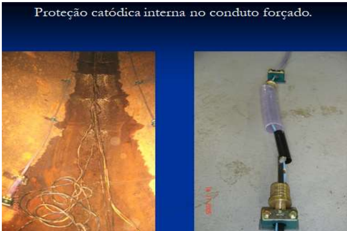
Figura 59: Instalação de corrente impressa no conduto forçado
