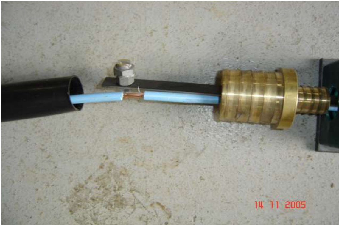
Figura 26: Vista no detalhe conexão ao anodo de barra chata de titânio de sacrifício da proteção catódica Fonte: acervo do autor (2005)
