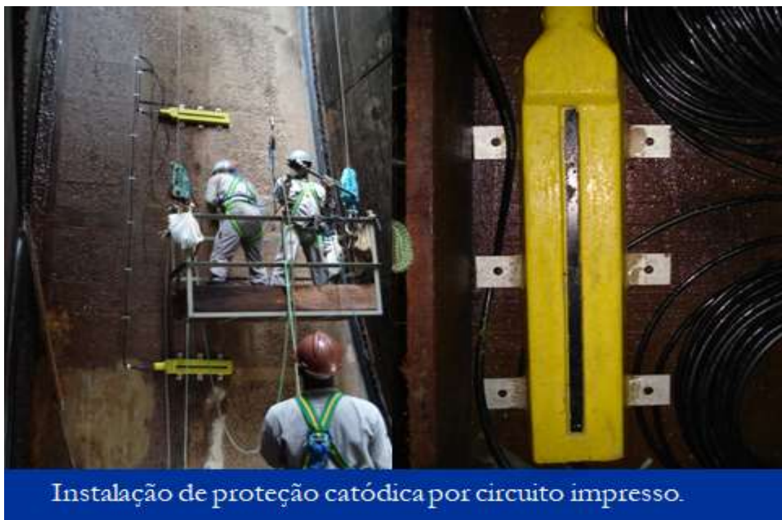
Figura 58: Instalação de sistema de proteção catódica na comporta. No detalhe a caixa de alojamento do anodo de sacrifício de titânio.
