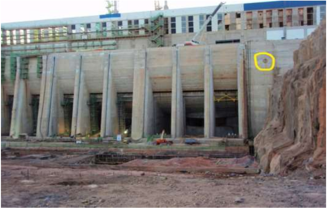
Figura 48: localização da entrada da captação alternativa na hidrelétrica Estreito. Fonte: acervo do autor (2010)
