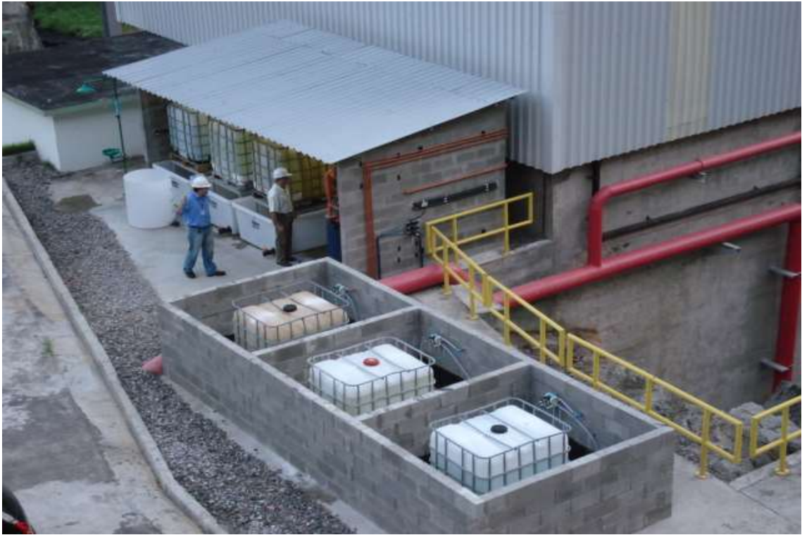
Figura 76: Edícula e baias de tanques de produtos químicos biocidas.
