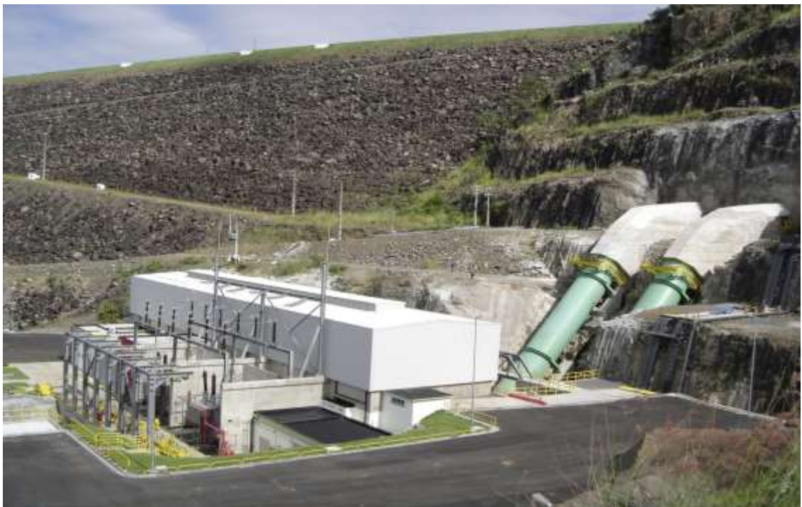
Figura 50: Vista da casa de força da Usina Pedra do Cavalo
