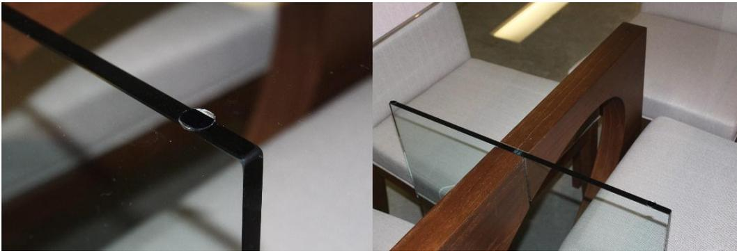
Figura 5.5: Peça de silicone entre a base da mesa e o tampo de vidro
