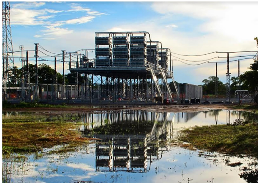
Figura 50 - Banco de capacitores série (Fonte: GE)
