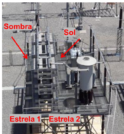
Figura 9 – Sombreamento heterogêneo
