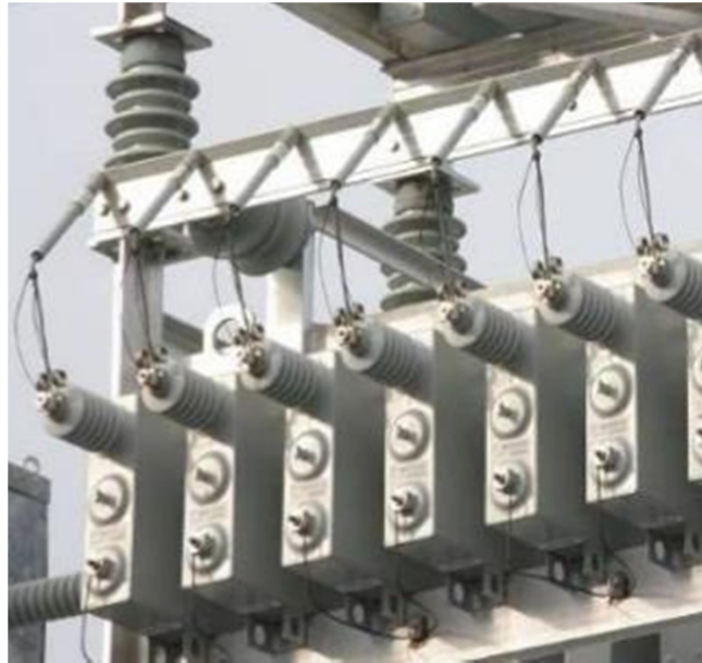
Figura 23 – Exemplo de banco de capacitores com fusível externo [11]
