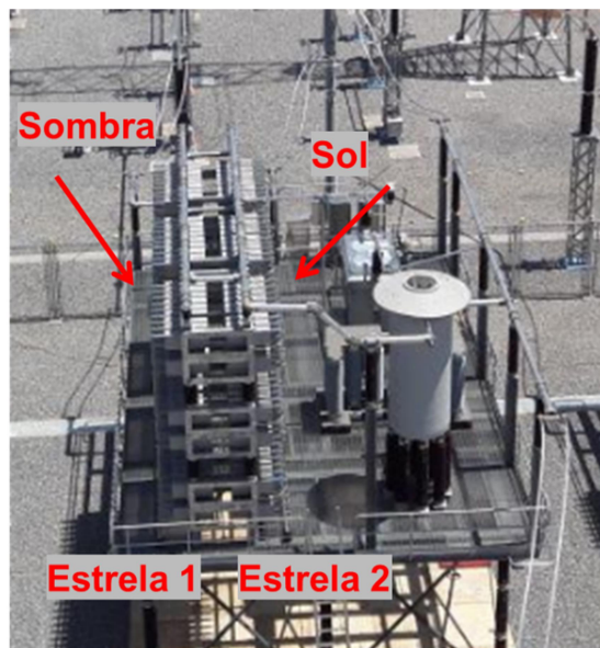
Figura 51 - Caso de sombreamento heterogêneo (Fonte: GE)
