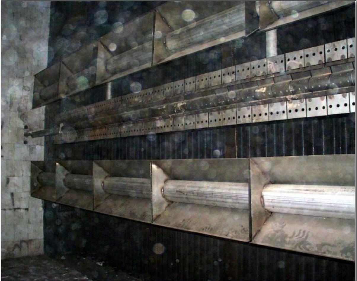
Figura 30 Foto de um queimador de duto do tipo em linha.
