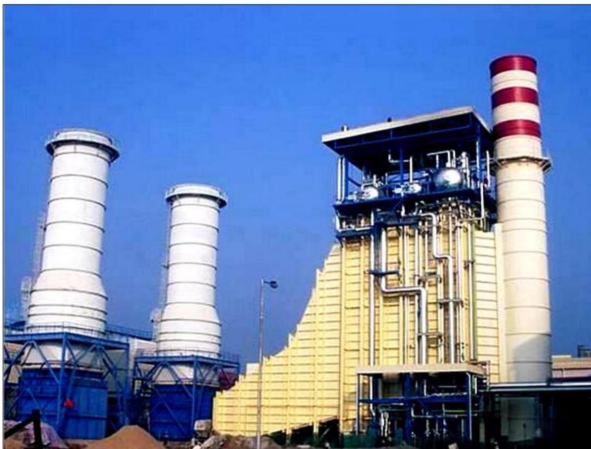
Figura 20 Foto de uma HRSG com 3 Estágios de pressão e reaquecedores.
