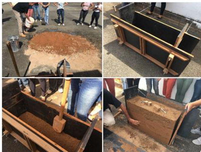
Figura 1 - Processo Construtivo da terra compactada
