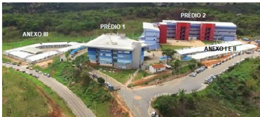
Figura 6 - Foto aérea do Campus de Itabira
