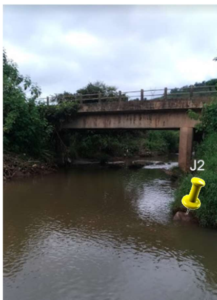
Figura 13 – Imagem de parte do Rio do Peixe onde está indicado o ponto de coleta de amostra de água denominado J2 que está a jusante da ETE municipal
