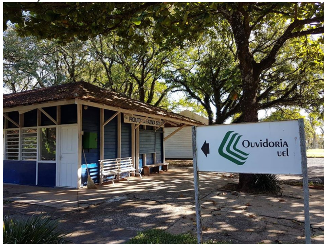
Figura 4.2 - Instalações da Ouvidoria da Universidade Estadual de Londrina
