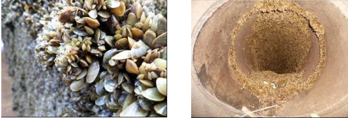
Fig. 7 - Incrustação de adultos de mexilhão dourado das grades de tomada de água da usina geradora de Igarapava e Obstrução da tubulação de água do sistema de resfriamento da usina geradora de Salto Caxias. Fonte: [4]
