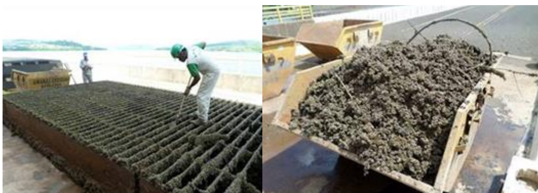
Fig. 1 - Limpeza manual das grades da tomada de água dos geradores da usina hidrelétrica de Igarapava/SP. A caçamba apresenta o volume de descarte de mexilhões retirados no processo de limpeza. Fonte: [4]
