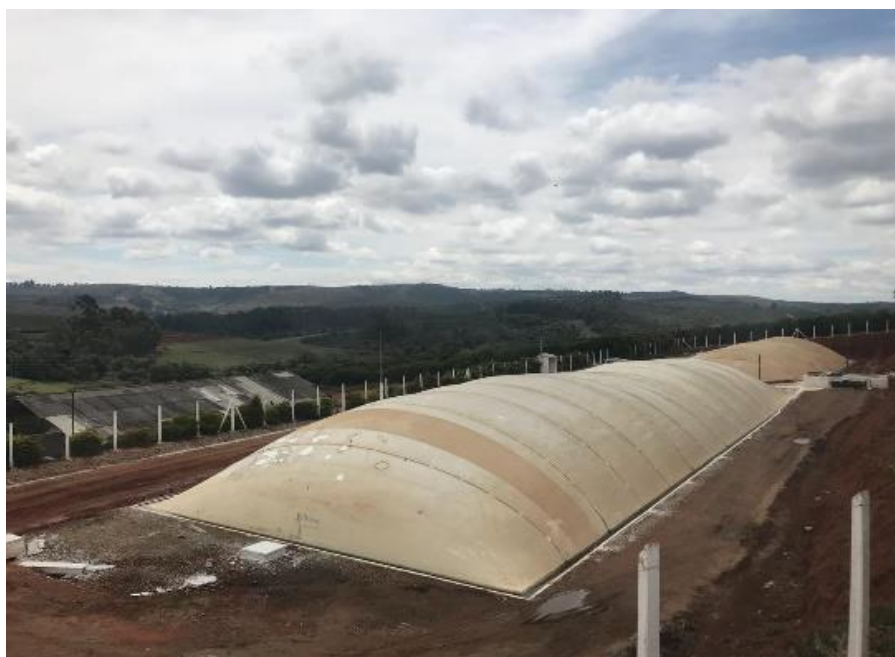
Figura 3.2 - Biodigestor de lagoa coberta da Fazenda modelo – Oliveira - MG.
