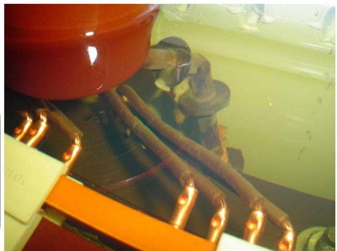
Figura 4.2 – Dobra no fio de alta tensão
