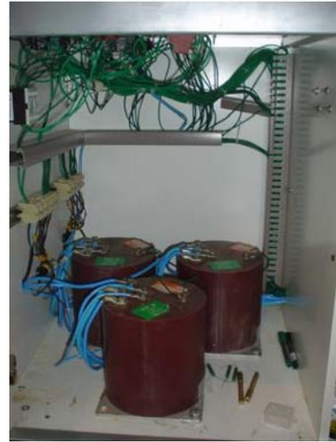
Figura 3.19 – Detalhes dos TCs
