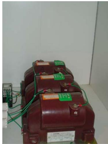
Figura 3.21 – Detalhes dos TPs
