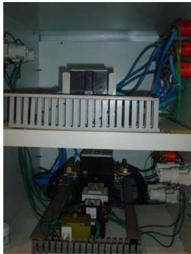
Figura 3.20 – Detalhes dos contatores e fusíveis
