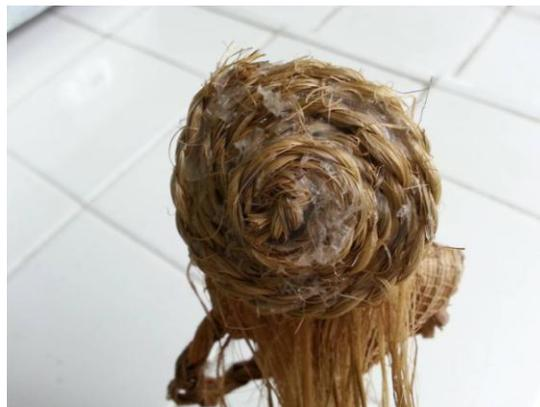
Figura 62 - Degradação da fixação das cordas de sisal da composição do chapéu
