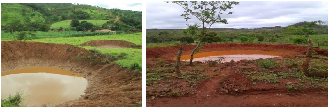
Figura 2 – Fotos de bacias de contenção “Barraginhas” implantadas no Brasil. Fonte: Agência Peixe Vivo/CBH Velhas, 2019.
