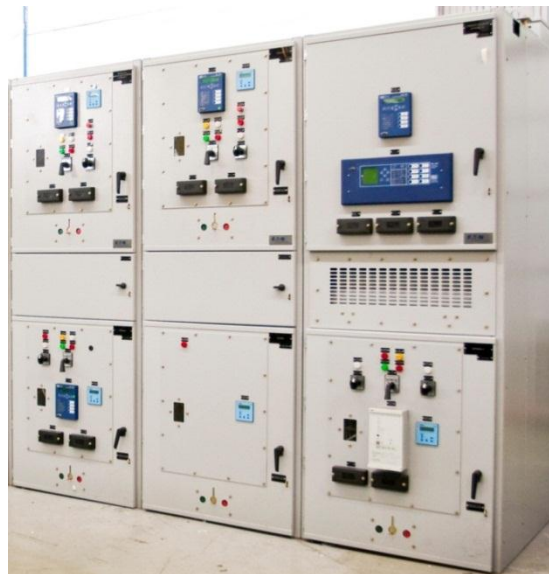
Figura 6.7- CMCP de MT, padrão ANSI, com dois disjuntores por coluna
