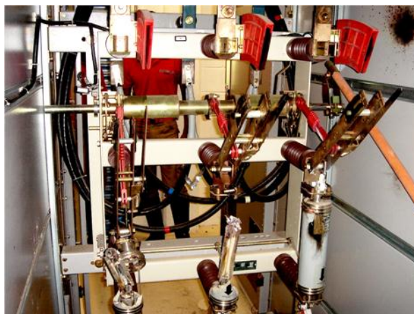
Figura 6.16- Uso inadequado de elementos fusíveis limitadores de corrente
