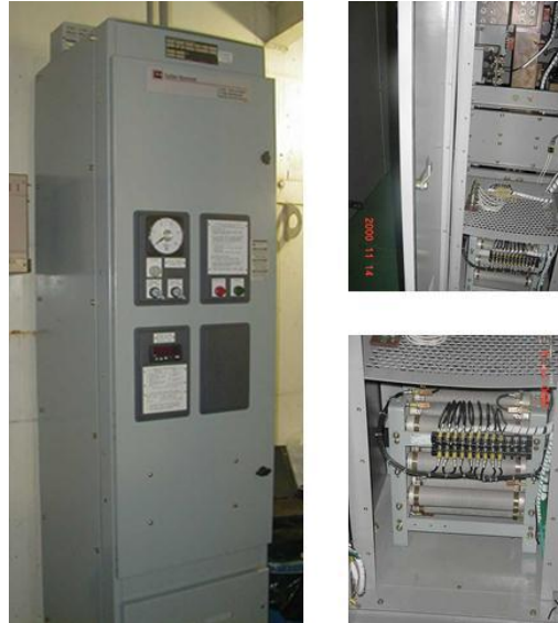
Figura 6.15- Aterramento por alta resistência do neutro de um sistema de 480 / 277 V
