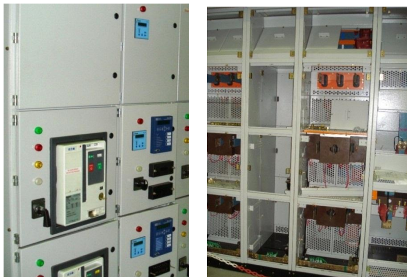
Figura 4.20- CMCP-BT com forma de separação “4b” e proteção secundária
