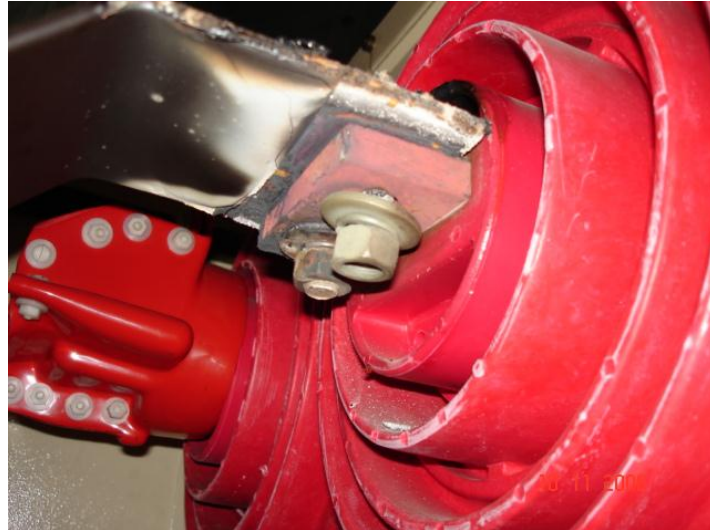
Figura 6.26- Detalhe da conexão defeituosa mostrada na Figura 6.25
