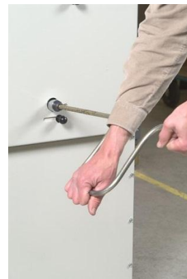
b- Movimentação do elemento extraível
