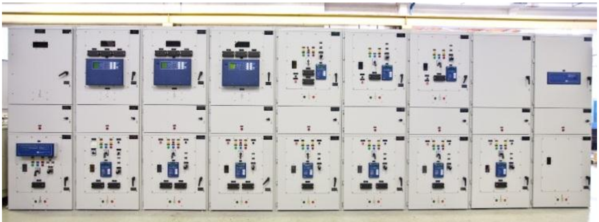
Figura 3.1- Vista frontal de um CMCP de MT
