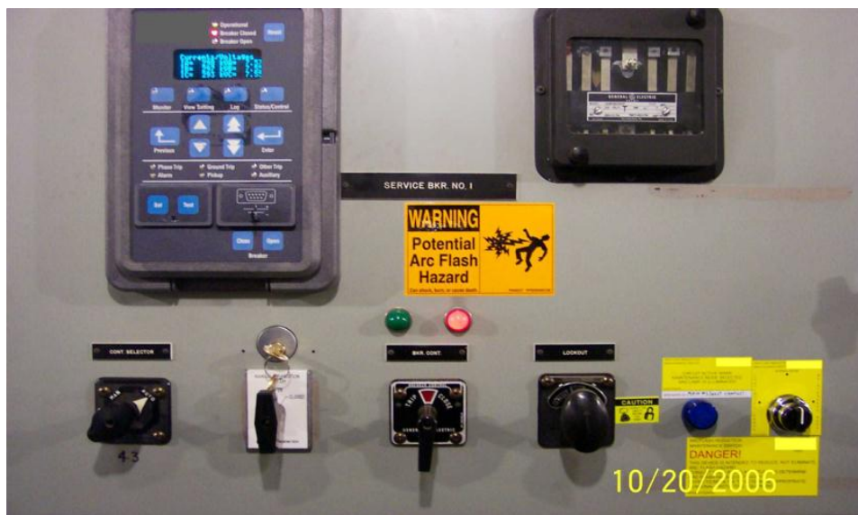
Figura 6.18- Sistema de redução de energia incidente através da mudança do grupo de ajustes da proteção
