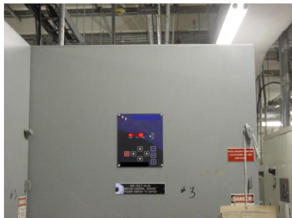
Figura 6.24- Unidade microprocessada de monitoração contínua de DP
