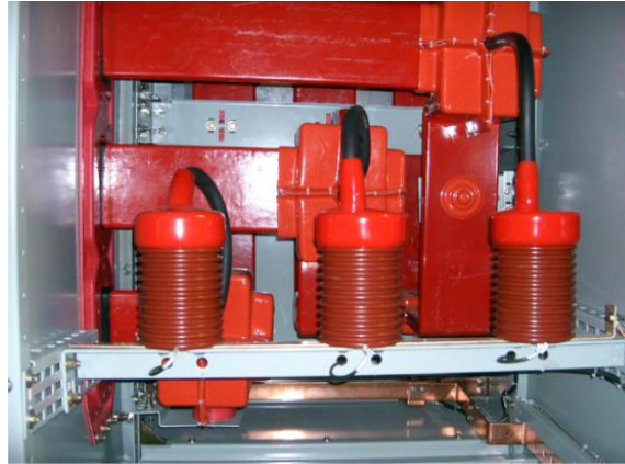
Figura 6.23- Acopladores capacitivos para monitoração contínua dos níveis de DP
