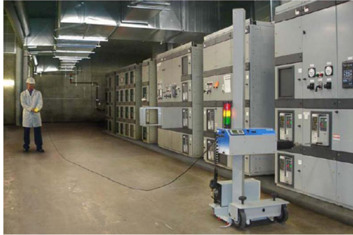
Figura 6.12- Operação remota de movimentação de elemento de manobra extraível
