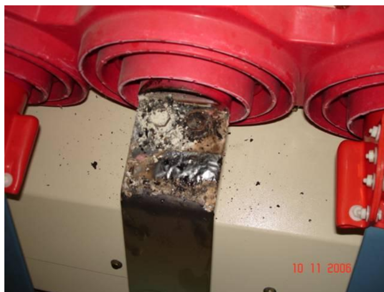
Figura 6.25- Conexão de saída de dispositivo com sinais de sobreaquecimento
