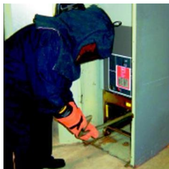
Figura 6.10- Operação de movimentação de elemento de manobra extraível
