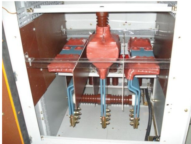
Figura 3.14- Configuração interna do CMCP de MT ensaiado para verificação do NBI
