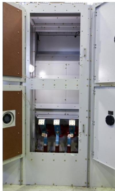
Figura 6.22- Instalação de janelas termográficas
