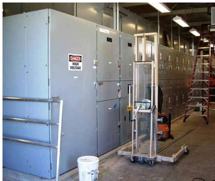
Figura 6.5- Vista frontal do CMCP mostrado na Figura 6.4
