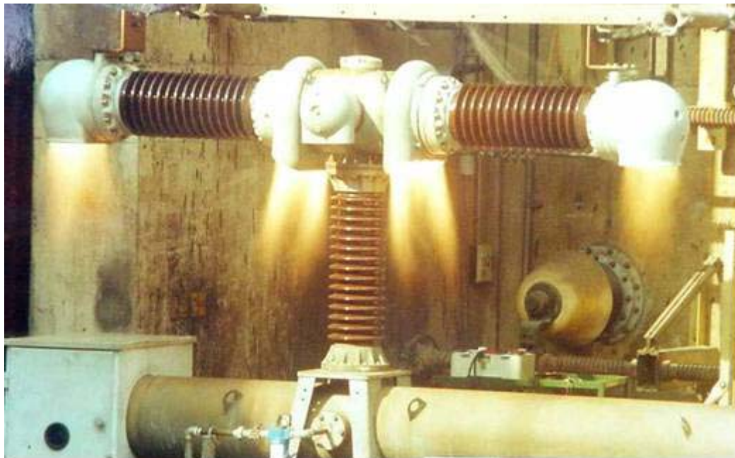
Figura 4.5 — Vista completa de um disjuntor a ar comprimido
